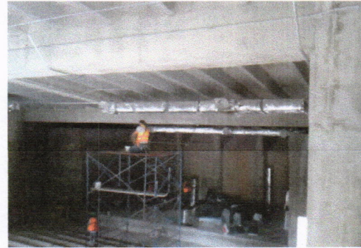
Instalación de ductos del Sistema de Aire Acondicionado en el Auditorio.
