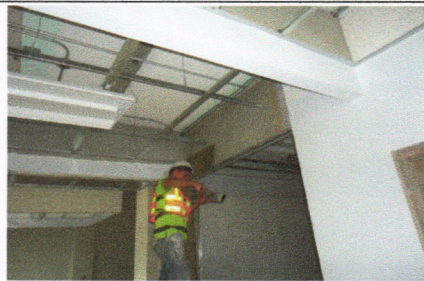
Vista de acabado en el pared de durock e instalaciones
