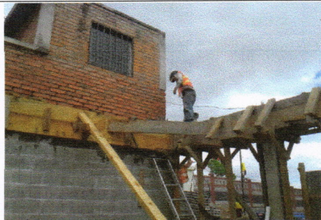
Fundición de viga en Cuarto de Máquinas de Odontología.
