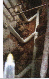
Instalación de tuberías de aguas residuales
