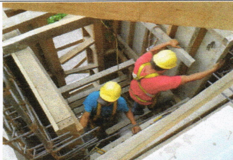
Encofrado de paredes de cubo de elevador en el Edificio de Biblioteca.
