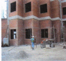
Módulo B: Levantamiento de pared de ladrillo visto en fachada posterior.
