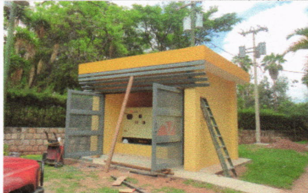
Vista instalación de portón y estructura metálica E-1 en caseta de generador
