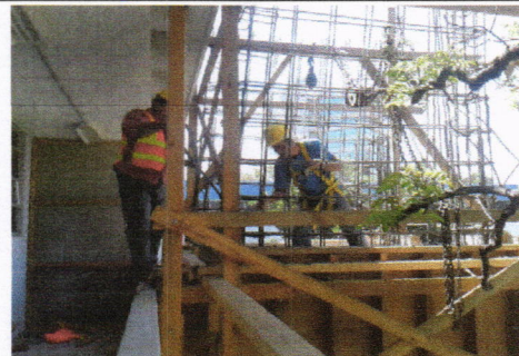
Fundición de paredes de cubo de elevador en el Edificio de Biblioteca.
