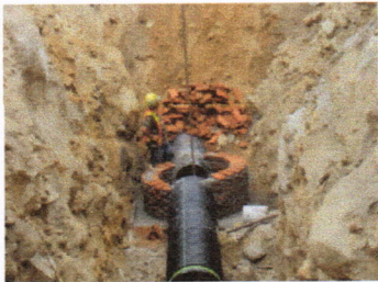
Módulo A: Construcción de pozo de inspección en red tuberías aguas lluvias para conectar a red municipal.
