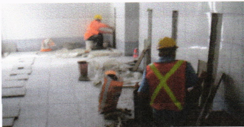
Pegado de piso de granito
