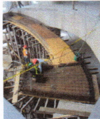
Módulo D: Encofrado de segundo tramo de gradas circulares.
