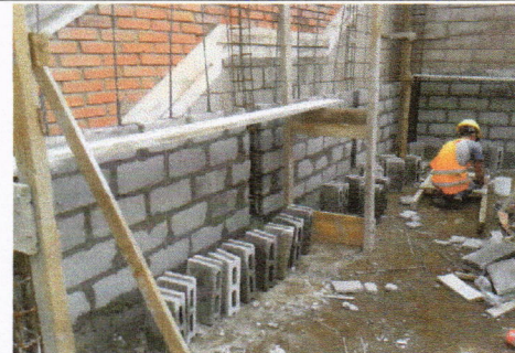
Construcción de paredes en Cuarto de Máquinas de Odontología.
