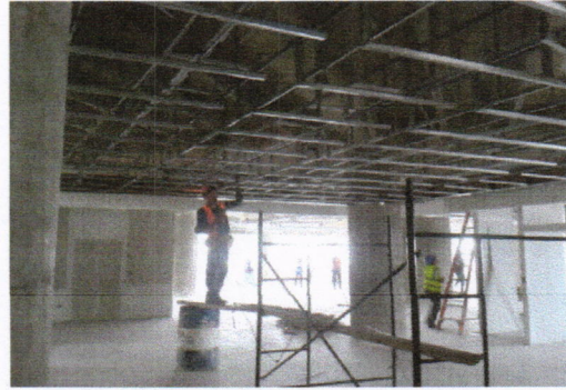
Instalación de flejería de cielo falso en niveles de oficina.
