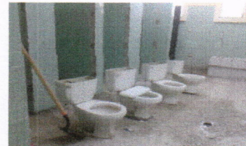
Desmontaje de sanitarios
