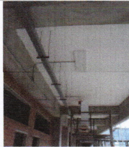
Modulo A: Colocación de Lámparas en pasillos.
