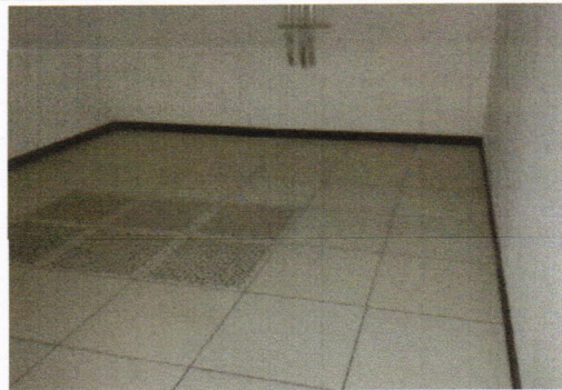
Instalación de piso falso en Cuarto de Datos del Sótano.
