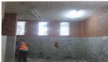
Trabajos de demolición
