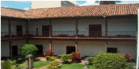
Vista desde el patio interno del edificio
