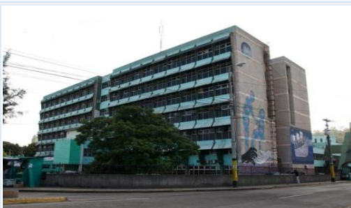
Vista este del Hospital Escuela Universitario
