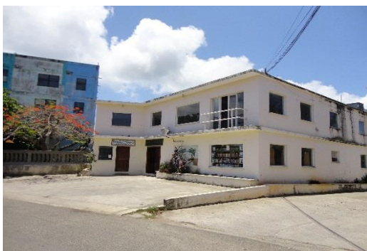
Edificio asignado por la Municipalidad de Roatán, situación antes de iniciar la readecuación.
