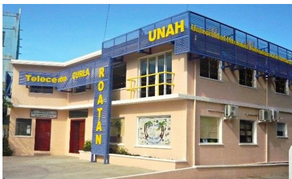
Finalización de la readecuación para el edificio del Telecentro Universitario de Roatán
