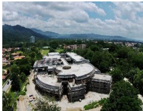
Vista aérea del proyecto
