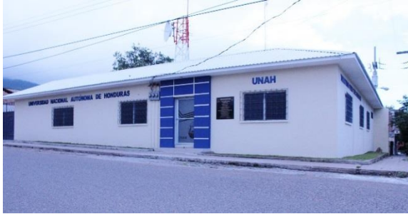
Finalización de la readecuación del edificio para el Telecentro UNAH CUROC Ocotepique
