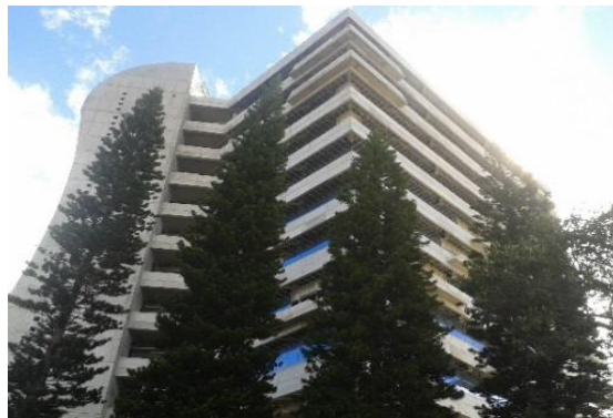
Vista de la fachada oeste
