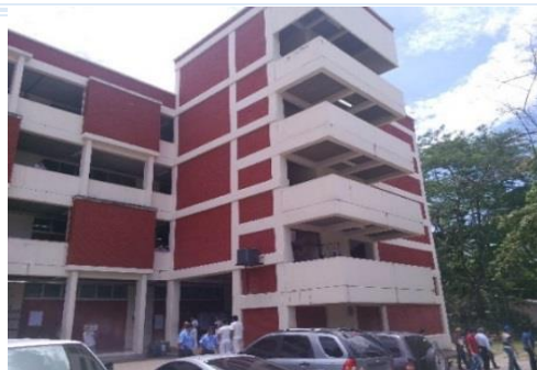
Vista del Edificio No.5
