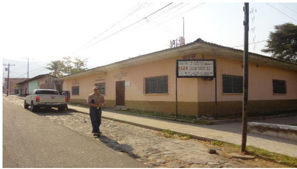
Edificio asignado por la Municipalidad de Ocotepique, situación antes de iniciar la readecuación.
