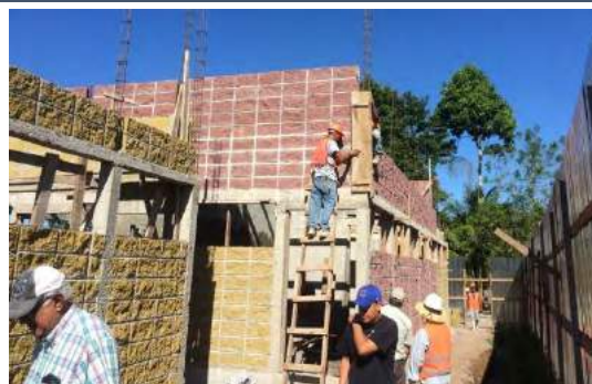
Levantamiento de paredes. Vista lateral: módulo de desinfección
