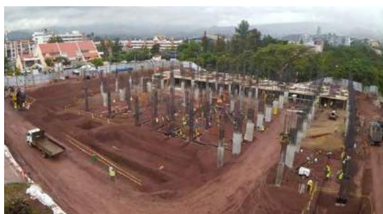
Vista Noreste del edificio. Avance de obra en cimentación y armado de columnas en el nivel de estacionamiento E2
