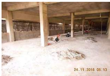
En la imagen se observa la demolición de piso de concreto que será sustituido por piso de terrazo en el 4 nivel.
