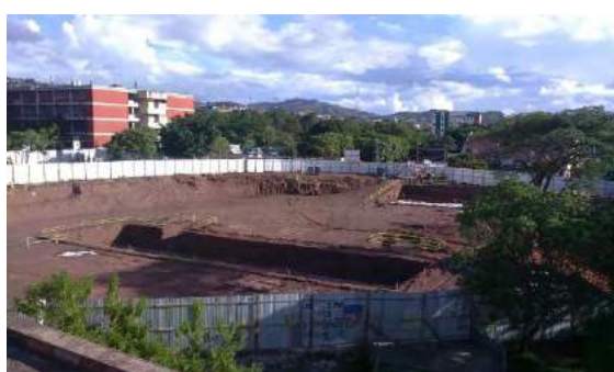
En la imagen se observa excavación estructural para construcción de zapata combinada
