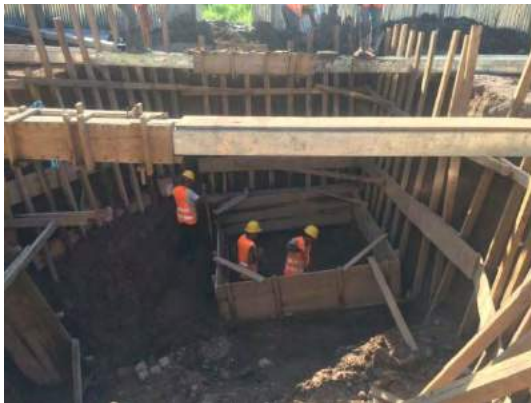
Excavación, encofrado de zapatas y colocación de concreto de nivelación
