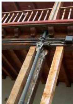
Primer nivel: Se observan corredores en el primer nivel y apuntalamiento de los elementos estructurales por deterioro de la columna existente.
