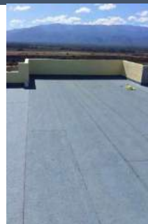
Impermeabilizante en azotea 2
