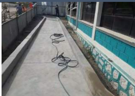
Construcción de Rampa de acceso al edificio
