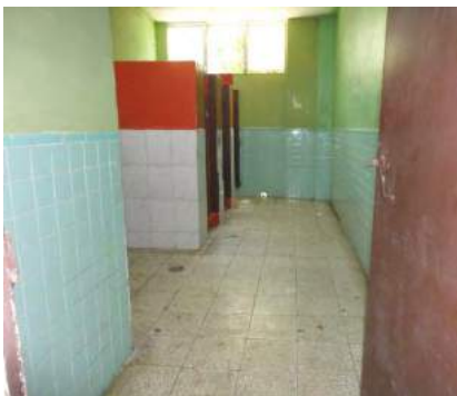
Servicio sanitario de mujeres en Edificio No.1
