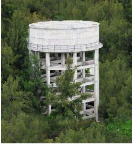
Imagen del tanque tipo de abastecimiento propuesto, actualmente en construcción
