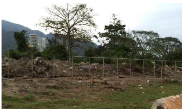
Avance de la obra. Colocación de cerco de malla ciclón
