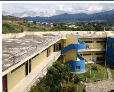
Situación inicial losa existente azotea 1
