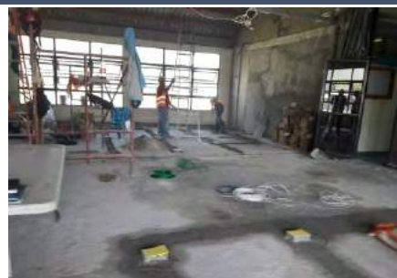
Instalación de cajas eléctricas de piso
