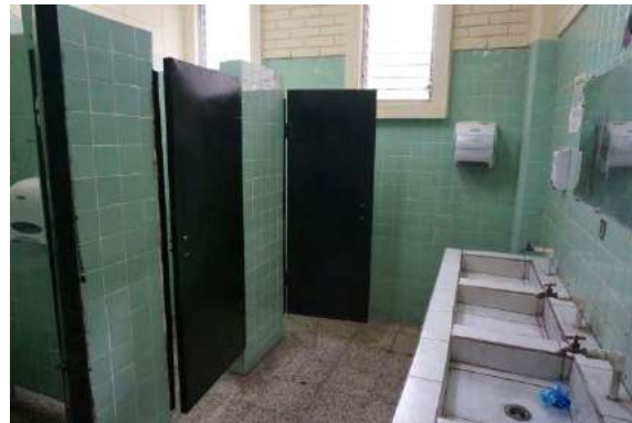
Servicios sanitarios Edificio No.2
