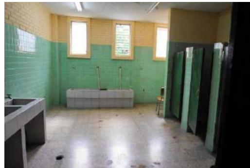
Servicio sanitario de hombres en Edificio No.4
