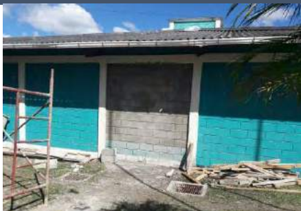
La imagen muestra sellado de boquete
