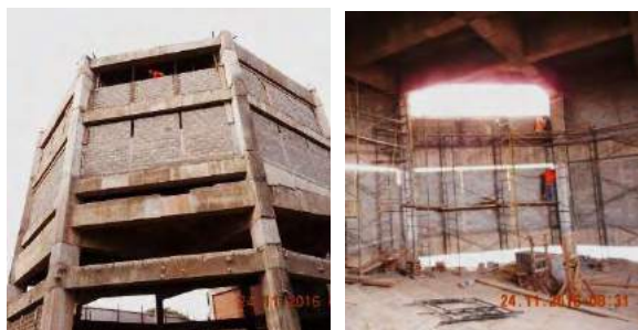
Vista parcial de construcción de paredes de bloque de 6" en exterior Auditorio #1 e interior Auditorio #2
