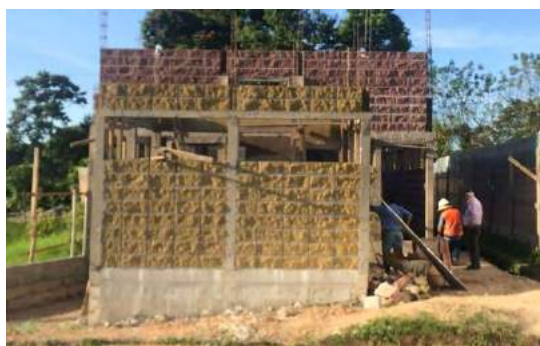
Levantamiento de paredes. Vista posterior: lavandería del módulo de desinfección.
