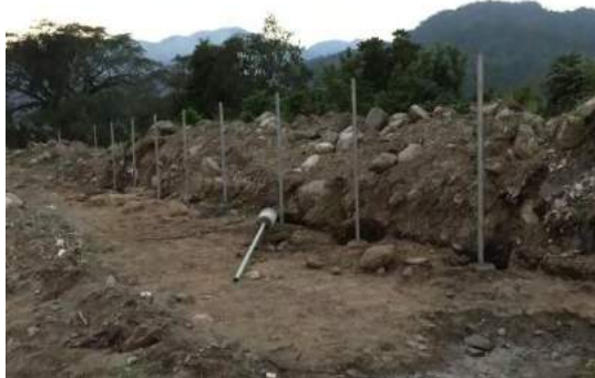
Instalación de cerco de malla ciclón
