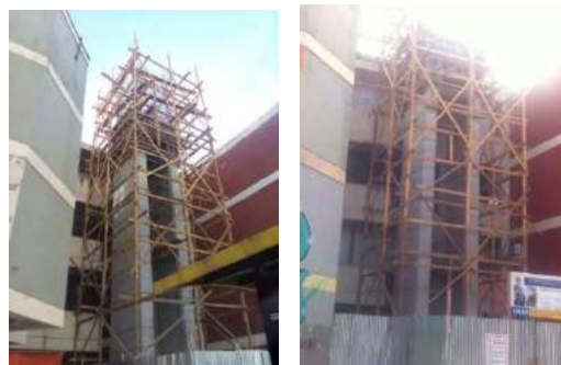
Imágenes que muestran la construcción de los cubos de elevadores en los edificios D1 y F1
