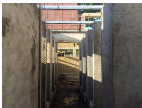
Levantamiento de paredes. Sanitarios de Hombres en el módulo de desinfección
