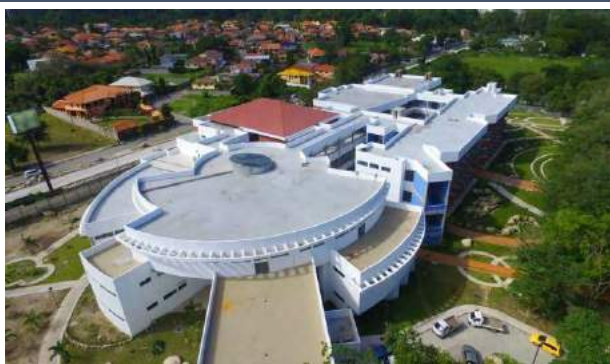
Vista aérea del Complejo de Edificios
