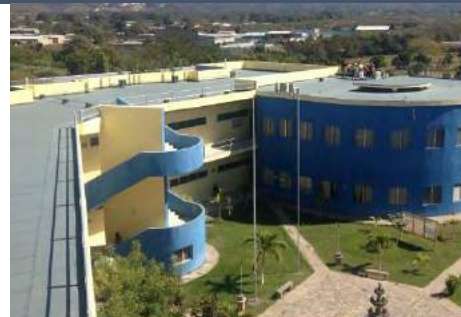
Vista Panorámica de azotea 1
