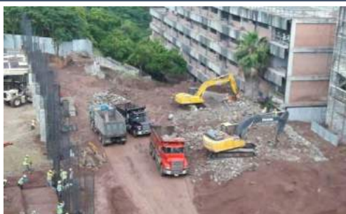
En la imagen se observa corte de material donde se construirá el modulo C del Edificio 1847 en el cual se ubicará la cocina y el comedor universitario
