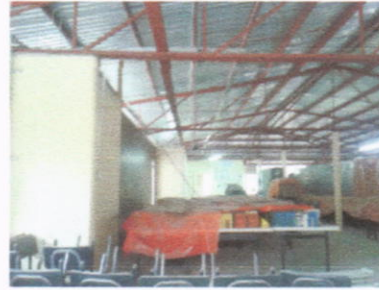
instalación de techo en biblioteca
