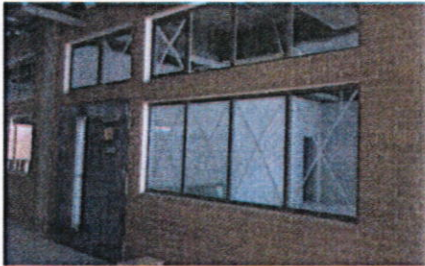
Módulo C: Suministro e instalación de puertas y ventanas.
