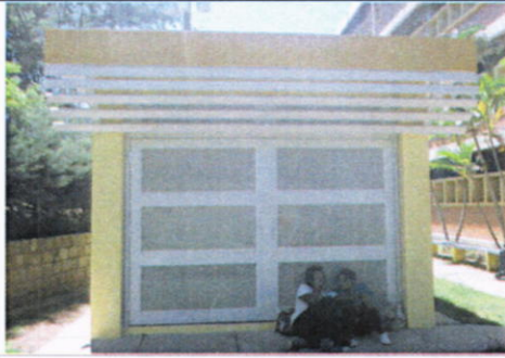
Caseta del Generador para Laboratorio de Servicios Genéticos
