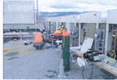
Llenado del sistema de aire acondicionado con refrigerante.
