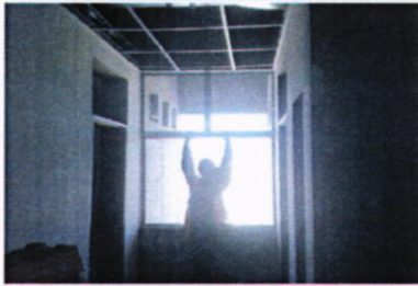
Instalación de ventanas en diferentes niveles.
