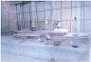
Instalación de difusores de sonido en Auditorio.
