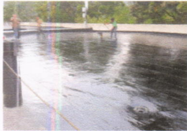
Impermeabilización de losa en edificio No.2
