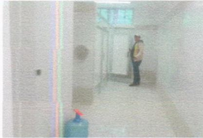
Módulo de mujeres finalizado en edificio No 1
