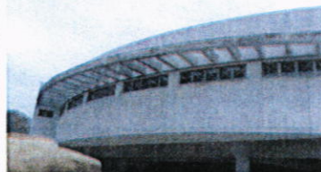
Módulo D: Suministro e instalación de ventanas.
