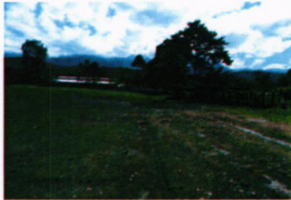
Vista de Construcción de fosa séptica del módulo de desinfección personal (31-01-2017)
