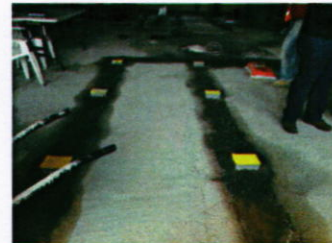
Instalación de cajas eléctricas
