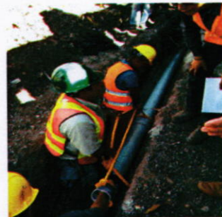
INSTALACION DE TUBERIA 8" DE Ø PVC SDR-17 ASTM D2241
