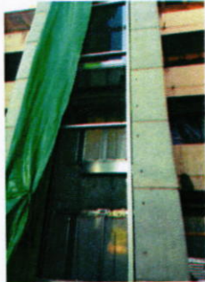
Vista de montaje de elevador y marco de ventana
