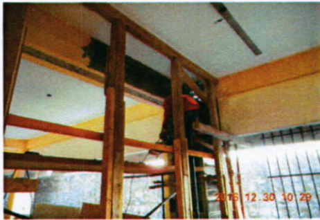
Demolición de viga de rigidez
