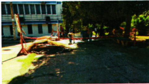
Vista de fundición de firme de concreto sobre ruta de tuberías eléctricas de línea de media tensión, frente a Auditorio Juan Lindo
