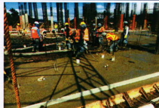
Fundición de sección de losa de Nivel 1.
