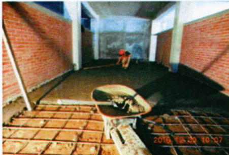
Fundición de firme de concreto
