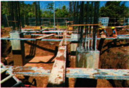
Pedestales (3) de Concreto, fundidos y desencofrados (Grupo Sur-Oeste). 31-01-2017
