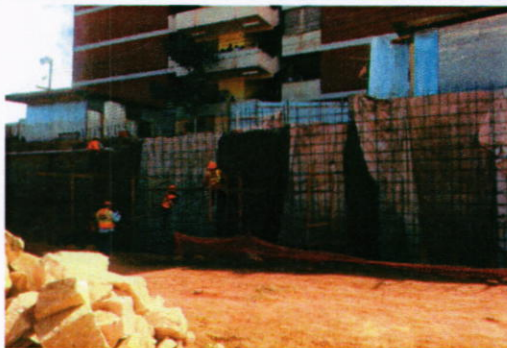
Armado de acero de refuerzo de muros del lado este.
