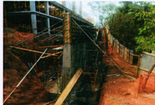
Encofrado de muro de contención en lado oeste.
