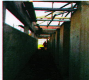
Vista de Repello de paredes interiores módulo de desinfección personal (31-01-2017)
