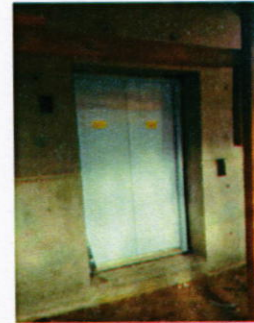
Vista de puerta de cubo de elevador
