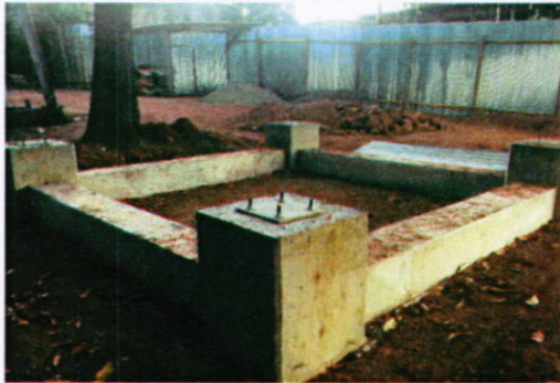
Base para tanque metálico por reubicar.
