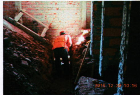
Excavacion para instalación de tuberías de aguas negras en baños
