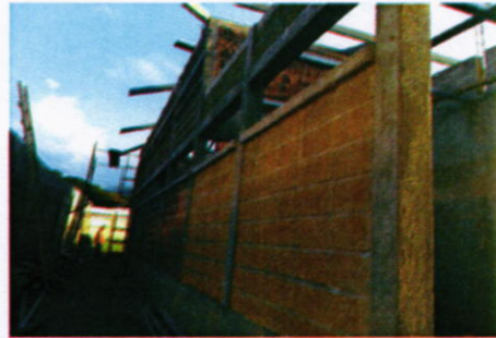
Vista de levantamiento de paredes de bloques de concreto (splitface) en el módulo de desinfección personal (31-01-2017)
