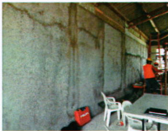
Repello de paredes
