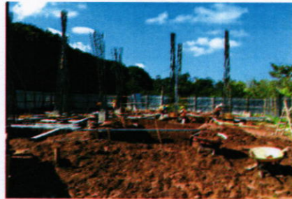
Excavación de zanjas para fundición de Zapatas (3), Grupo Nor-Este). (31-01-2017)
