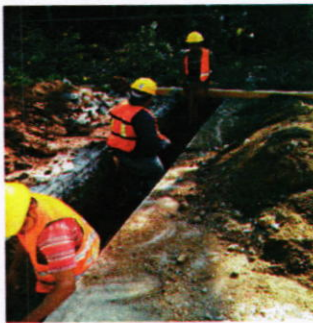
ZANJO PARA INSTALACION DE TUBERIA DE 0.70 M ANCHO Y 1.42 M ALTO
