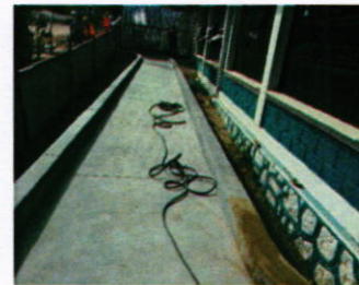
Construcción de rampa de acceso
