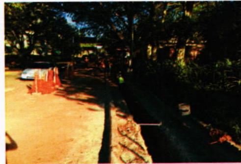
Excavación para línea de agua potable.
