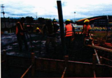
VACIADO DE CONCRETO FUNDICION DE LOSA SUPERIOR DE CISTERNA
