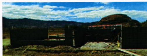
Levantamiento de Paredes de Concreto de 6", laboratorios CURLP
