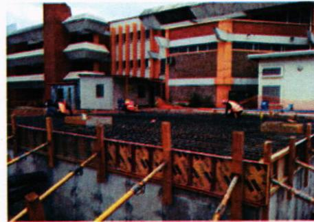
ARMADO DE ACERO LOSA SUPERIOR DE CISTERNA
