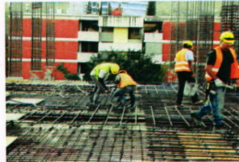
Armado de acero de refuerzo en losa de Módulo A.
