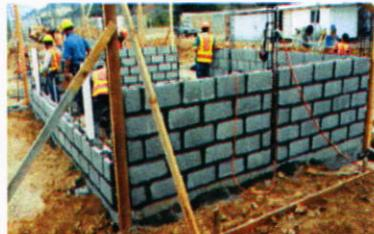
Levantamiento de Paredes de Concreto de 6", UNAH-TEC-DANLI
