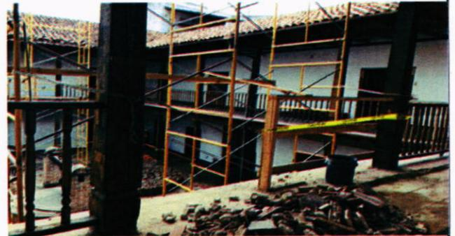
Desmontaje de barandal de madera y demolición de piso
