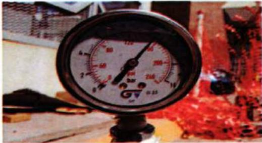
MANOMETRO CON PRESION DE PRUEBA HIDROSTATICA EN TUBERIA INSTALADA
