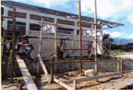
Vista de acabado de estuco en castillos y soleras fachada norte módulo de desinfección personal (21-04-2017)
