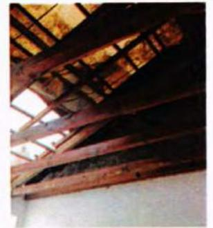
Retiro e identificación de piezas de madera en mal estado y protección con plásticos de paredes de adobe
