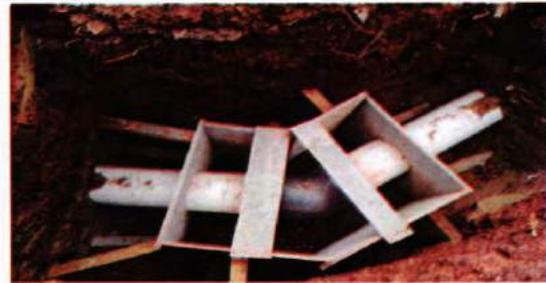
ENCOFRADO PARA LA CONSTRUCCION DE ANCLAJE DE CONCRETO SIMPLE EN CODO DE 45°X8"
