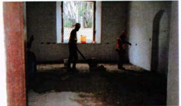
Instalación de 30 cm de Material Selecto previo a la instalación de pisos
