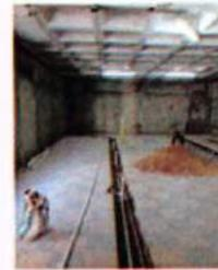
Instalación de nuevas instalaciones agua potable, desagüe, succión y eléctricas
