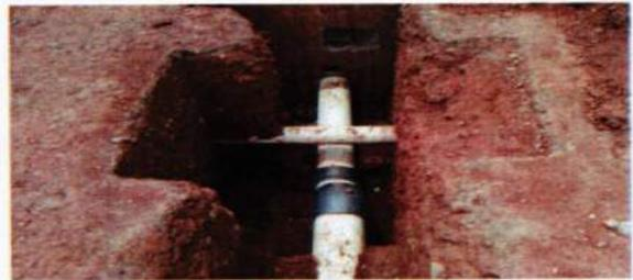
CONSTRUCCION DE VASO COMUNICANTE ENTRE AMBAS CISTERNAS PARA LLENADO DE AGUA A LA NUEVA CISTERNA CON TUBERIA 8" DE Ø
