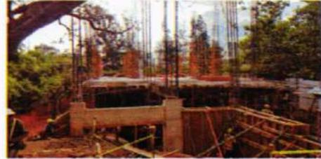
Fundicion de Losa de primer nivel ejes de 1A al 4A y de a' al c
