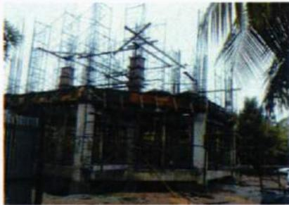
Vista de Armado y Encofrado de columnas entre Nivel 1 y Nivel 2
