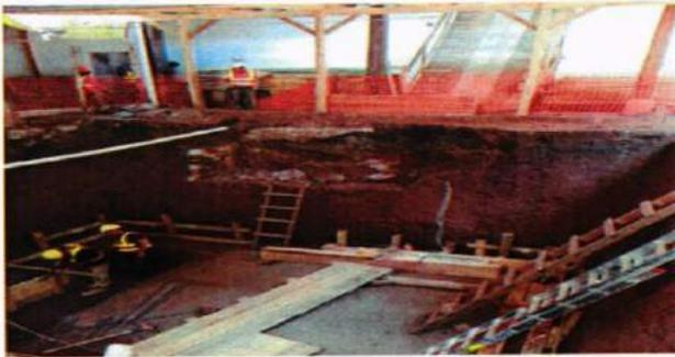
Se ha realizado al 100% la excavación de la cisterna y se ha fundido la losa inferior de la
