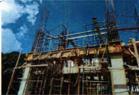
Vista de Armado de columnas entre nivel 1:+4.00 y nivel 2:+8.00; 25-06-2017)
