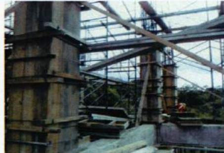
Vista de Encofrado de Columnas entre nivel 1:+4.00 y nivel 2:+8.00; 25-06-2017
