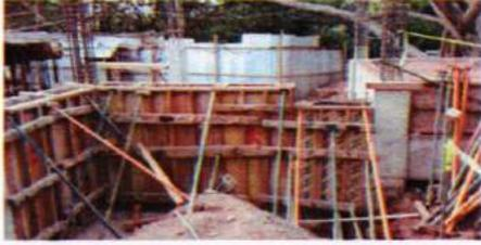
Encofrado de muros de concreto armado MC-01
