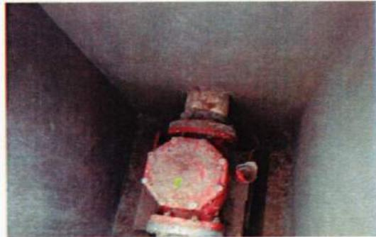
CAJA PROTECTORA Y DADO SOPORTE DE APOYO DE VALVULA CHECK DE 8" DE Ø
