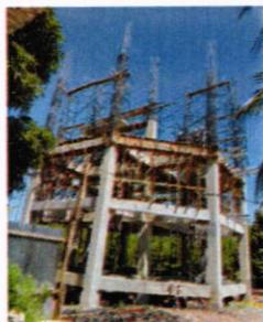
Vista de Armado y Encofrado de columnas entre Nivel 3 y Nivel 4 31-07-2017
