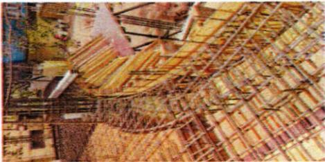
Encofrado y armado de losa circular 1er nivel
