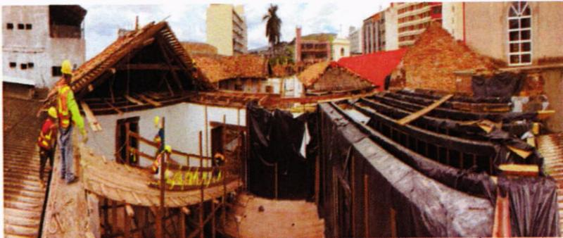
Se avanza en desmontar estructura de de techo existente y en la estructura de madera de la losa de entrespiso, igual que columnas de madera en mal estado
