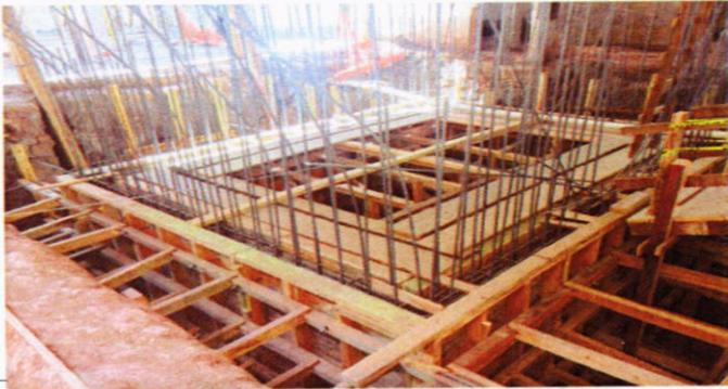
Se ha fundido la losa inferior de la cisterna y se tiene listo para la fundición de las paredes
