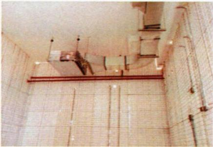
Instalación de ductos, unidades evaporadoras y tubería contra incendio.
