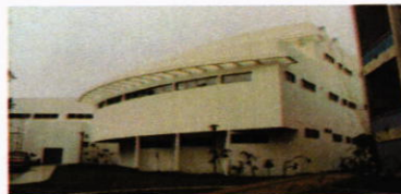
Fachada Sur, Modulo D
