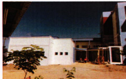
Fachada frontal del edificio, CURC
