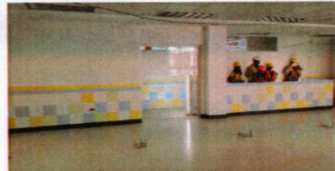
Instalación de piso de vinil, aplicación de pintura
