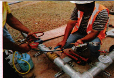
CORRECCION EN CALIBRACION DE SISTEMA DE AUTOMATIZACION
