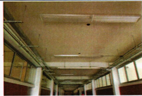
Instalación de Lámparas en Pasillo
