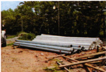
Vista de Descarga de Tubería de Nueva Línea de Conducción. 23-08-2017
