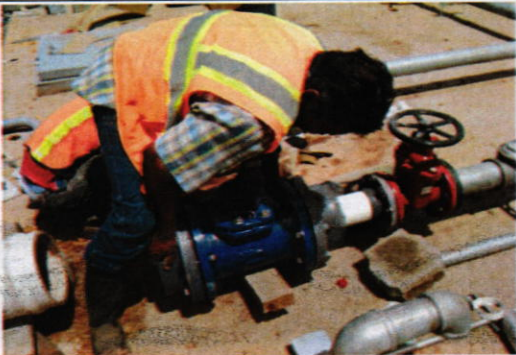
REPARACION EN TUBERIA Y ACCESORIOS DE FUGAS DE AGUA
