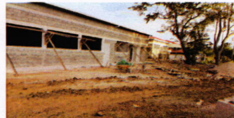
Fachada posterior, Planta Piloto de Innovación Alimentaria UNAH-TEC-DANLI
