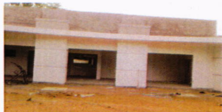
Fachada frontal Planta Piloto de Innovación Alimentaria, UNAH-TEC-DANLI
