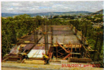
Vista aerea de encofrado de losa de entrepiso 4to nivel
