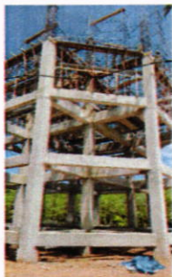
Vista de General de Avance de la Construcción del Tanque. Vigas del nivel 3:+12.00 y Columnas entre el nivel 3 y 4; 15-08-2017
