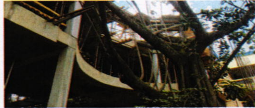
encofrado de viga circular losa de entrepiso
