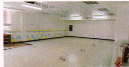
Instalación piso de lámparas y cielo falso
