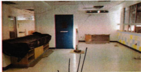
Instalación de puerta plomada
