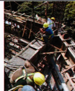
Vista de Fundición Vigas Perimetrales Nivel 3:+12.00; 26-08-2017
