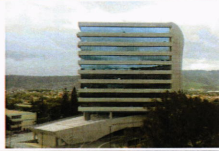
Vista sur-este del edificio.
