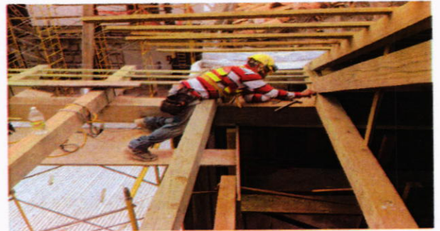
Instalacion de estructura de madera para techo: 11 Tijeras en ala este y 11 en ele ala oeste, vigas
