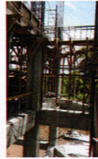
Vista de Armado de Acero y Encofrado de vigas de Concreto del nivel 3:+12.00; 15-08-2017
