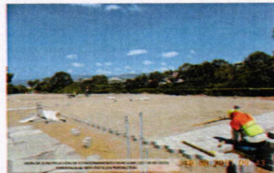
Adoquinado de estacionamiento para 104 vehiculos y 25 motos
