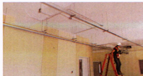
Vista interior, Pasillo de entrada, CUROC
