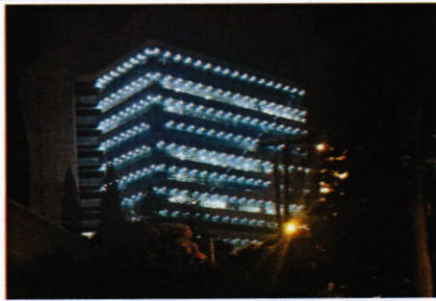
Vista oeste del edificio.
