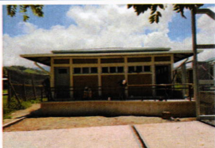
Vista de Facha Norte del Módulo de Desinfección Personal (30-08-2017)
