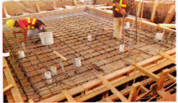
Armado de hierro para fundición de losa superior de Cisterna
