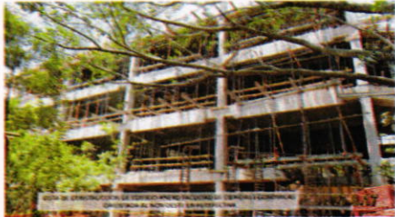
Avance de estructura del edificio C1
