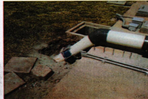
REPARACION EN TUBERIA Y ACCESORIOS DE FUGAS DE AGUA
