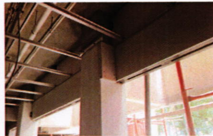
Instalación de cajillos, UNAH-VS
