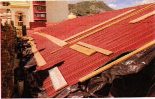
Instalacion de lámina onduline para posteriormente instalar la teja en ala este y oeste
