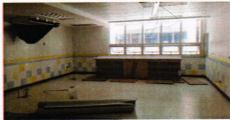
Instalación de Muebles fijos
