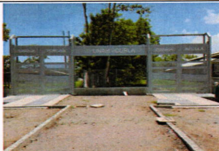
Vista de Portones de Acceso Vehicular a la Granja Porcina y Granja Avícola (30-08-2017)
