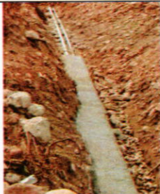
Vista de Instalacion de tuberia HG-SCH 6" de nueva Linea de Concuccion y tramo de tuberia HG-SCH 4" de linea de distribucion en la zona del cauce de la quebrada Quilina . 13-09-2017
