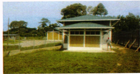
Vista de Módulo de Desinfección Personal fachada Sur. (18-09-2017)
