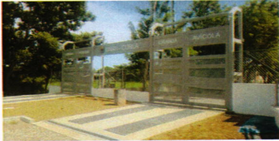
Vista de Portones y Arcos de desinfeccion vehicular de Granja porcina y Granja Avicola. (18-09-2017)
