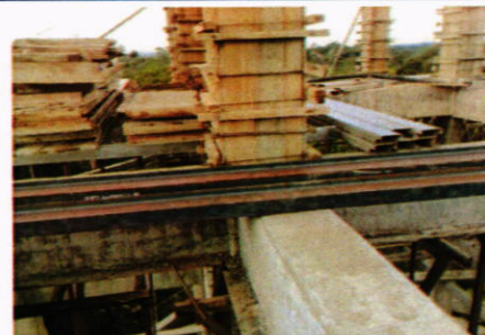
Vista de encofrado de columnas entre los niveles 4 y 5; 30-09-2017
