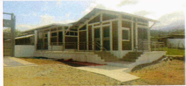
Vista de fachada Norte de Garita de Acceso y Módulo de Desinfección Personal (18-09-2017)
