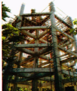
Vista del avance constructivo de la estructura del Tanque de Abastecimiento de Agua; 30-09-2017
