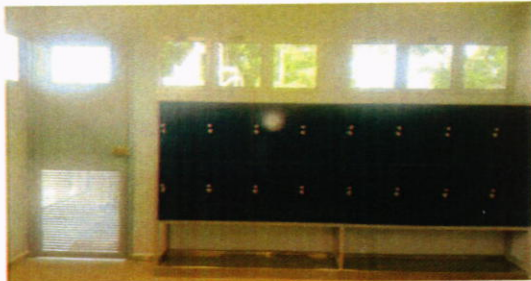
Vista de mobiliario del área limpia de hombres. Módulo de Desinfección Personal (18-09-2017)
