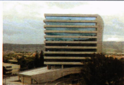
Vista sur-este del edificio.
