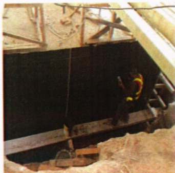
Se han instalado los impermeabilizantes de la cisterna, al exterior Igol Denso y en el interior Admix M-1 en un 50 %
