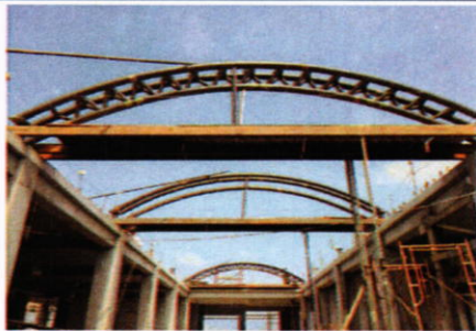
Instalación de estructura metálica de lucernario.
