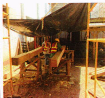
Se esta trabajando en el proceso de curado y tallado de la madera nueva que se esta instalando
