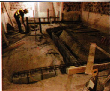
Se esta trabajando en las cimentaciones de los baños y en el ala norte del Proyecto
