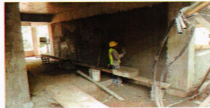
Repello en paredes planta baja y primer nivel
