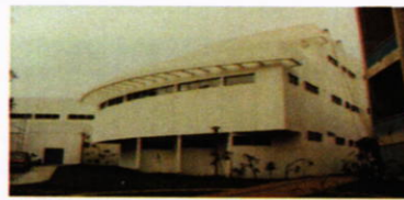
Fachada Sur, Modulo D
