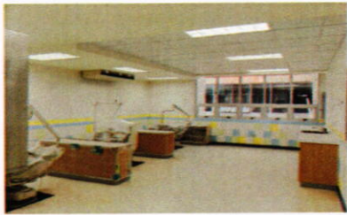
Instalación de Muebles fijos
