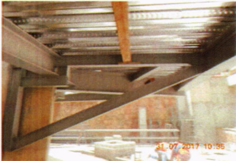
Estructura de la Rampa en Espiral
