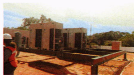
Instalación de unidades condensadoras de aire acondicionado, UNAH-VS
