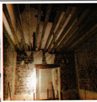
Se esta trabajando en cambiar la estructura de madera del entrepiso (largueros)
