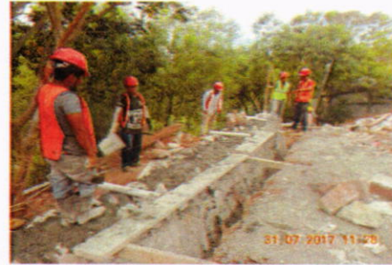
Muro de Mampostería en Lado Sur
