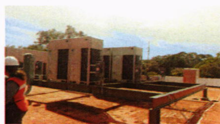
Instalación de unidades condensadoras de aire acondicionado, UNAH-VS
