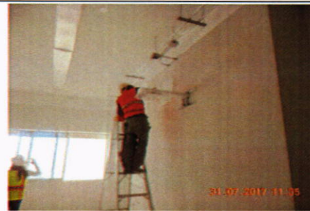
Instalación de Brazo para Proyectores
