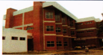
Fachada Norte, módulo B
