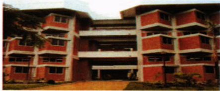
Fachada principal del edificio, módulo A
