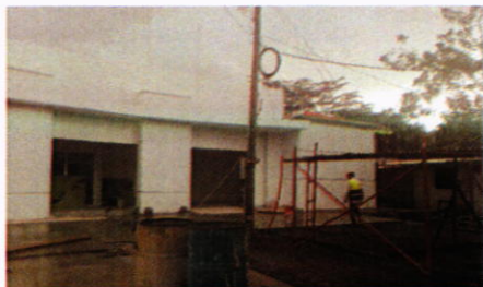
Fachada frontal, Planta Piloto de Innovación Alimentaria, UNAH-TEC-AGUAN
