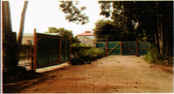
Se muestra la instalación de porton que permite acceso desde la calle
