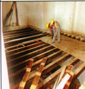
Se esta trabajando en cambiar la estructura de madera del entrepiso (largueros)
