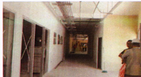
Vista interior, Pasillo de entrada, CUROC
