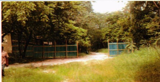
Instalación de cerco provisional a l interior del campus UNAH VS, para delimitar area asignada a la constructora INGELCO
