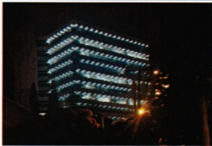
Vista oeste del edificio.
