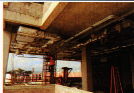
Instalación de ductos de aire acondicionado.
