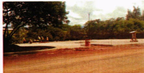
Finalización de adoquinado de estacionamiento para 104 vehículos y 25 motos
