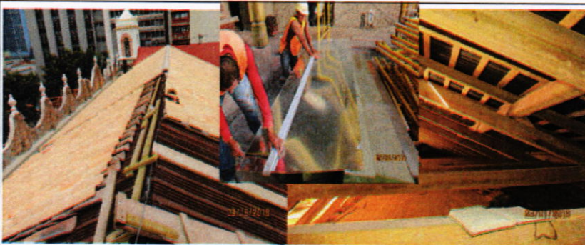
Se esta trabajando en la construcción e instalación de canales de lámina galvanizada para la recolección de las aguas lluvias del techo.
