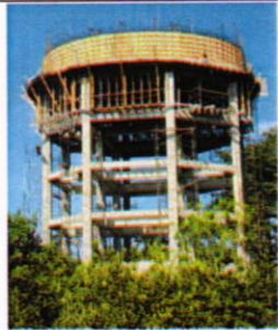
Vista de instalacion de moldes para fundicion de paredes del tanque elevado; 22-03-2018
