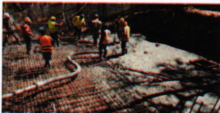
funcionidad de losa superior de cisterna
