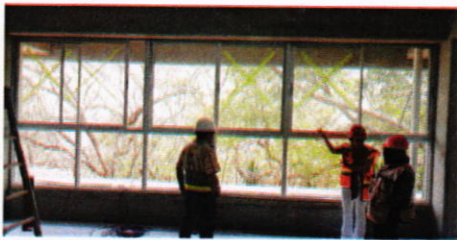
Instalación de ventanas en el edificio
