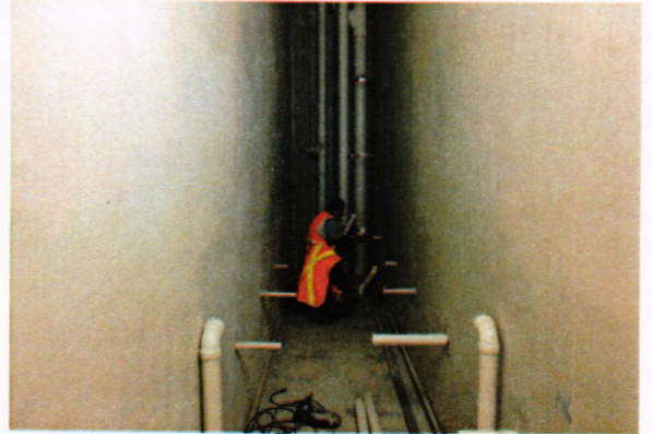
Instalación de tubería para agua potable en pasillos de servicio.
