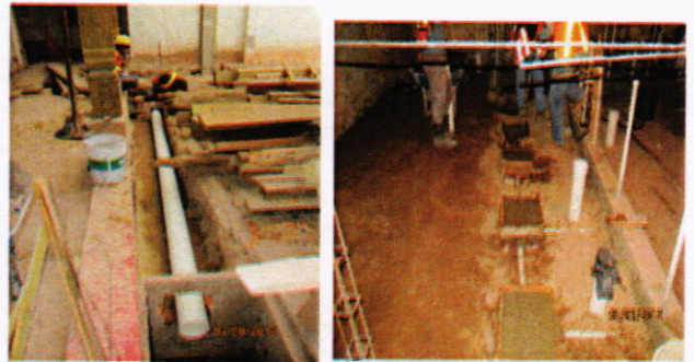
se continua trabaja en la instalación de las tuberías de los sistemas de Aguas Lluvias, Aguas Negras y Agua potable
