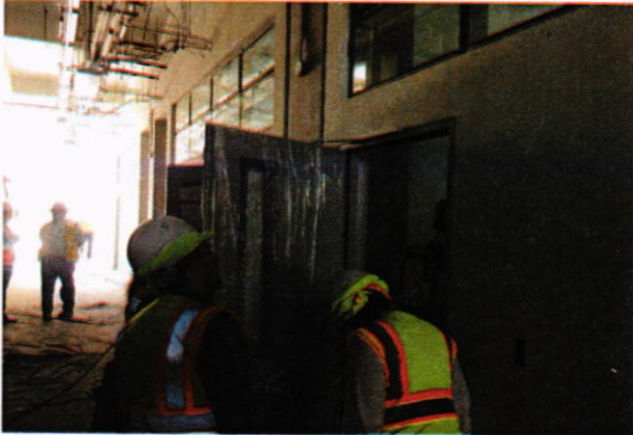
Instalación de puertas en aulas.
