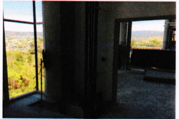
Instalación de tuberías de sistema de aire acondicionado.
