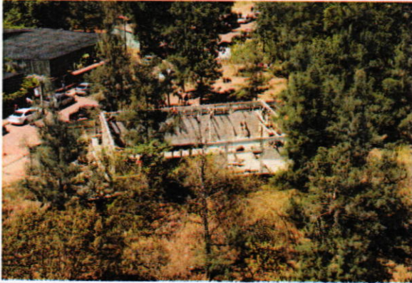
Construcción de cuarto de equipo de bombeo.
