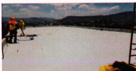
Instalación de Impermeabilizante en losa de techo
