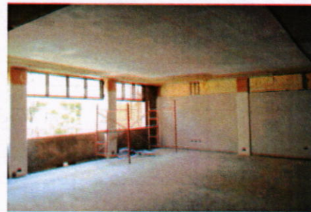
Repellos en paredes y losa ,en Laboratorio de Química, UNAH-VS
