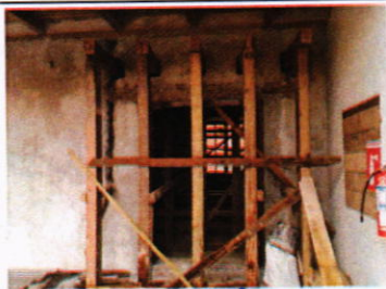
Se trabaja en la sustitución de piezas de madera sobre boquetes de puertas y ventanas
