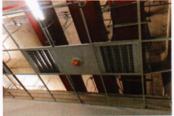
Instalación de lámparas y alarmas.
