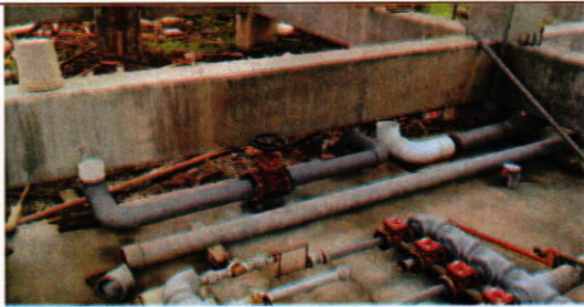
Vista de instalacion de tuberia y accesorios HG de 6" Ø, unidad de filtracion de sedimentos en la linea de conduccion ; 19-04-2018
