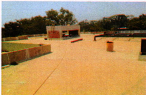
losa lista para impermeabilizar, UNAH-VS
