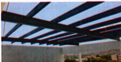
Estructura metálica en lucernario
