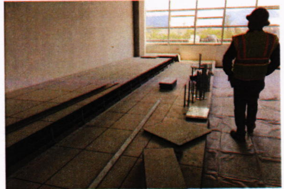
Instalación de piso elevado.
