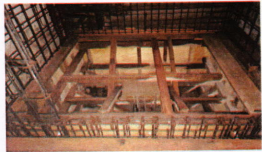
se continua trabaja en la fundición de las paredes de concreto armado del cubo del elevador y el resto de los elementos estructurales del ala norte
