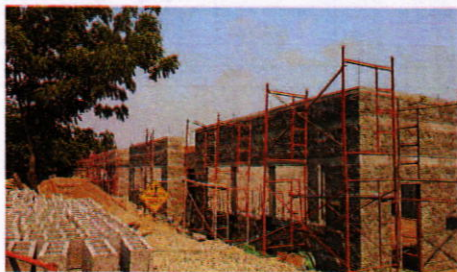
Fachada posterior, Planta Piloto de Innovacion Alimentaria, UNAH-TEC-AGUAN
