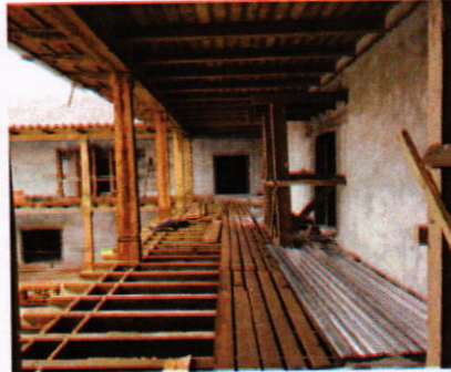
Se continua trabajando en el cambio de la estructura de losa de madera del entrespiso.
