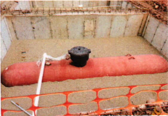
Instalación de tanque de gas LPG.
