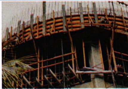
Vista de instalacion de encofrado de pared de concreto; 6-04-2018
