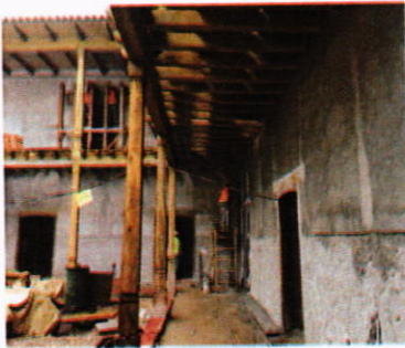
Se continua trabajando en el cambio de la estructura de losa de madera del entrespiso.
