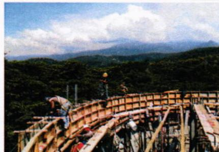
Vista de encofrado de vigas y losa de techo de tanque elevado; 17-05-2018
