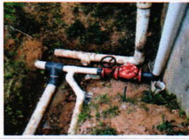
Vista de instalación de tubería y accesorios PVC 6" y 4"  $\phi$ , válvula de control de nivel y válvula de compuerta en el tanque existente; 17-05-2018
