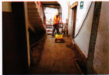
Se trabaja en la compactación de material en atierro de zanjos, de tuberías del sistema de aguas residuales y aguas lluvias.
