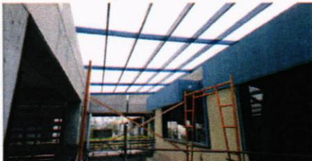
Estructura metalica en lucernario con cubierta de lamina traslucida.
