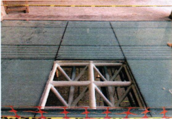
Instalación de piso de vidrio de puentes tridilosa.
