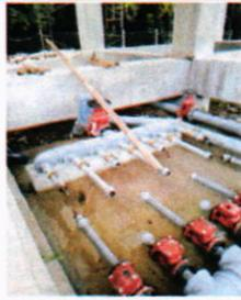
Vista de instalación de tubería y accesorios HG de 6"  $\phi$ , unidad de filtración de sedimentos en la línea de conducción; 17-05-2018
