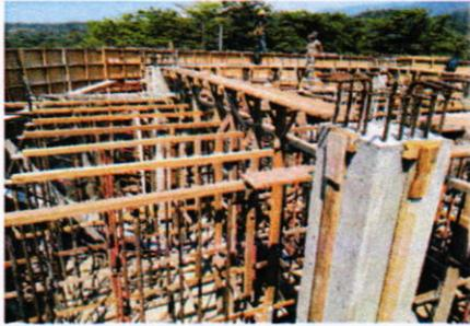
Vista de instalación de encofrado de vigas y losa de techo de tanque elevado; 17-05-2018
