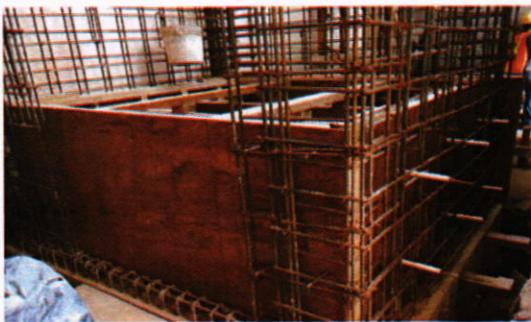
Se prepara encofrado de cubo de elevador para fundición.
