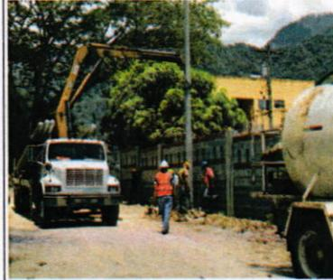
Inicio de colocación de postes de concreto de 30 pies de altura a una profundidad de 5 pies. Lado Norte
