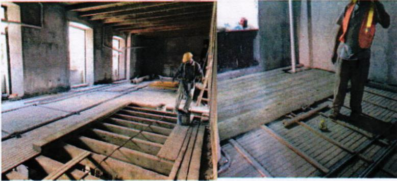
Se trabaja en las instalaciones de la estructura de madera de la losa de entresijos
