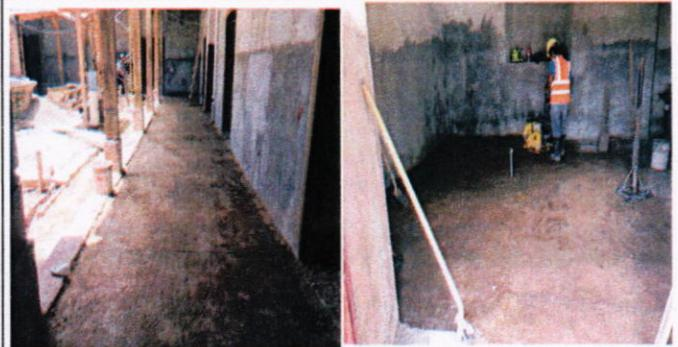
Se trabaja en la compactación de material selecto para posteriormente instalar firme de concreto para pisos.
