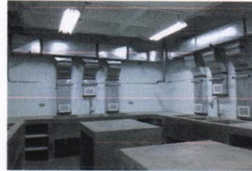
Sistema de extracción en cuarto oscuro, Laboratorio de Rayos X
