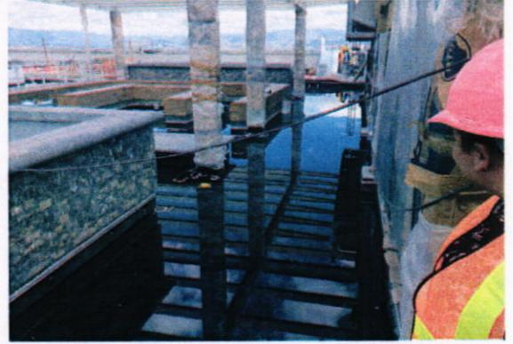
Prueba de estanqueidad en losa de Azotea.
