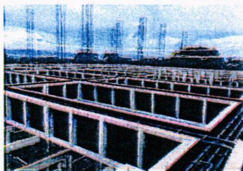
Encofrado de vigas Edificio de Aulas No. 1
