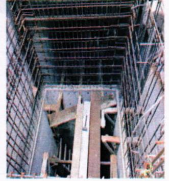
Se continua trabajando en la fundición de las paredes del cubo del elevador
