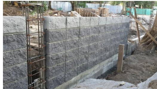
Avance en Muro Norte
