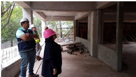
Visita de control y seguimiento, lado sur del edificio.
