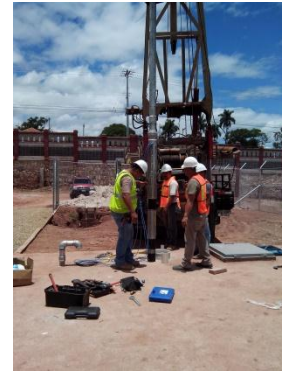
Instalación de bombas para cisterna
