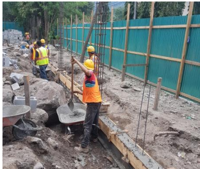
Avance en Muro Norte
