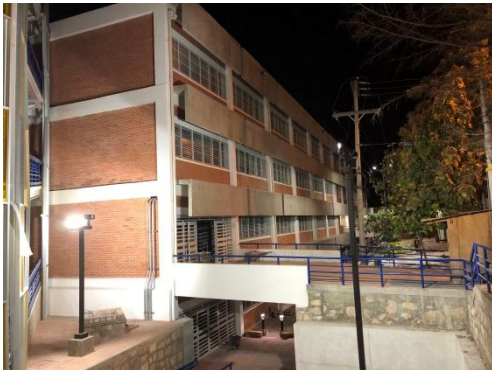
Vista de fachada y plaza norte del edificio
