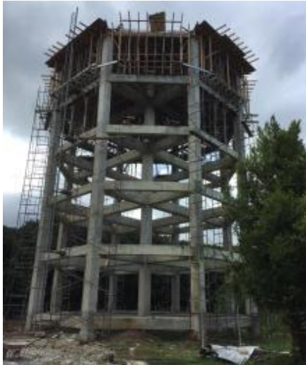
Avance de obra
