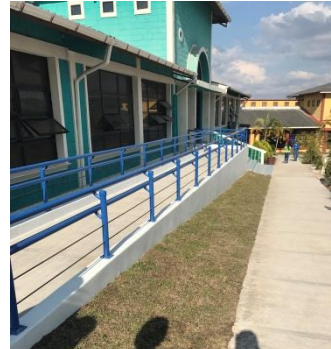
Rampa de acceso al Edificio No.1
