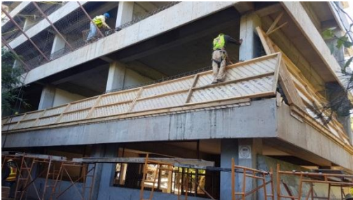
Vista noroeste del edificio, con área total de 3,310 m 2 distribuidos en cuatro niveles de aulas y un nivel de oficinas
