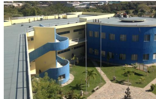
Obra finalizada en Edificio Principal
