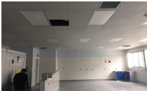
Vista interior área de procesos Planta Piloto
