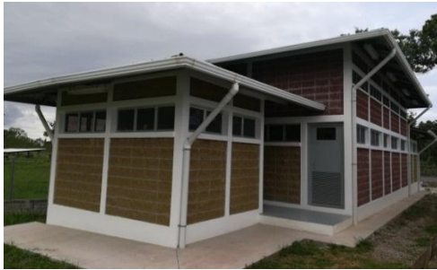
Vista posterior lavandería del módulo de desinfección.
