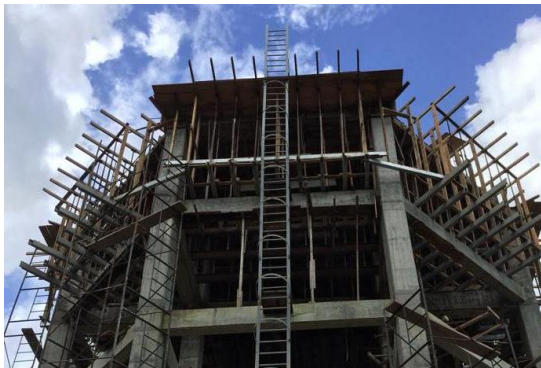
Encofrado de losa inferior del tanque
