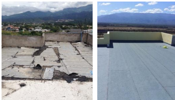
Situación inicial y obra finalizada en azotea 2
