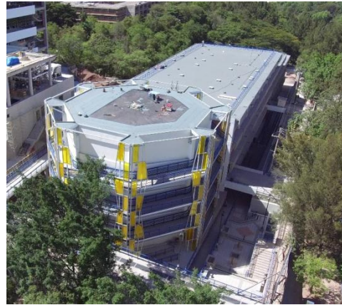
Vista aérea noreste del Edificio. Mostrando el avance de la obra
