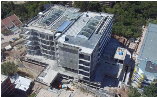
Vista aérea noreste del Edificio 1847
