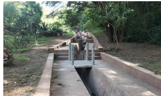
Construcción de canal de aguas lluvias en jardín botánico, como obra de compensación.
