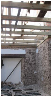
Cambio de estructura de techo, entrepisos, columnas y otros elementos de madera
