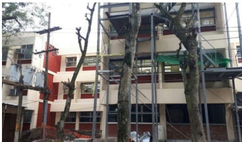
Fachada norte Edificio No.3
