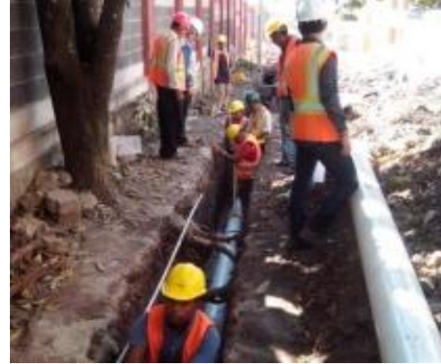
Instalación de tubería de PVC en proceso
