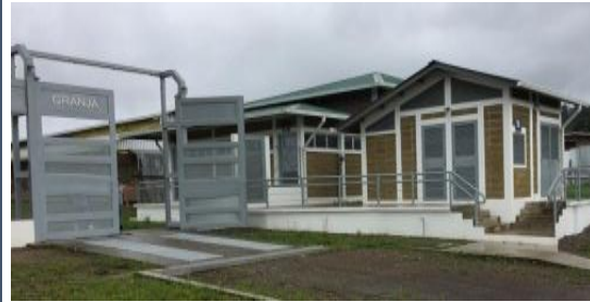
Vista de Garita, acceso principal y control de equipo
