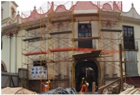
Vista fachada principal del Edificio, ubicado frente al parque de La Merced, Calle Bolívar, Tegucigalpa, M.D.C.
