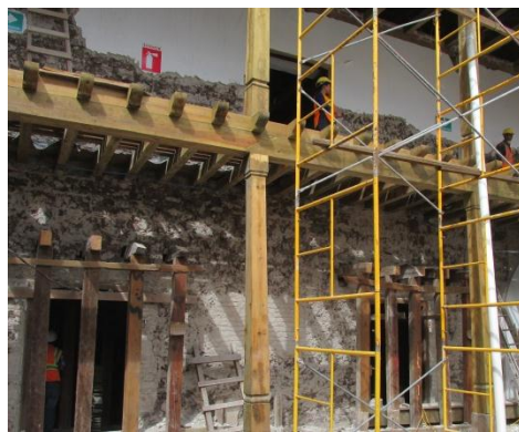
Cambio de estructura de techo, entrepisos, columnas y otros elementos de madera
