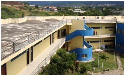
Situación inicial losa existente a impermeabilizar en Edificio Principal
