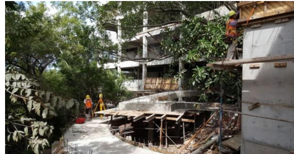
Rampa de acceso a nivel de planta baja, donde estarán ubicadas las oficinas administrativas
