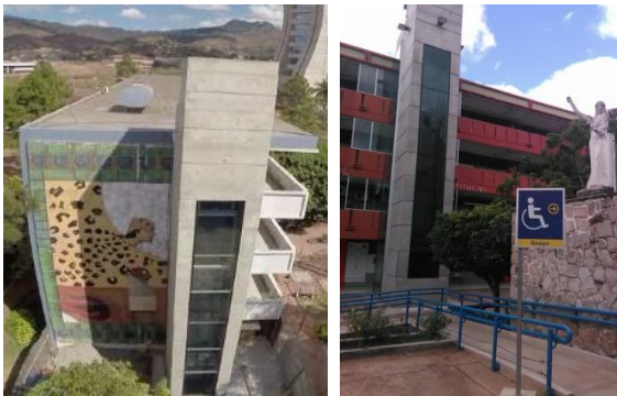
Elevadores en Edificios A1 Ciencias Sociales y A2 Ciencias Jurídicas
