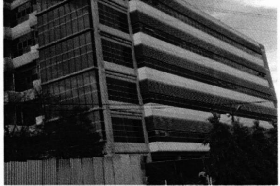
Vista de fachada sur del edificio
