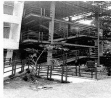
Vista interior laboratorio de química y gradas de emergencia UNAH-VS
