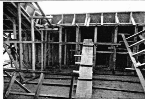
Encofrado de vigas de gradas. Edificio de Aulas No. 1
