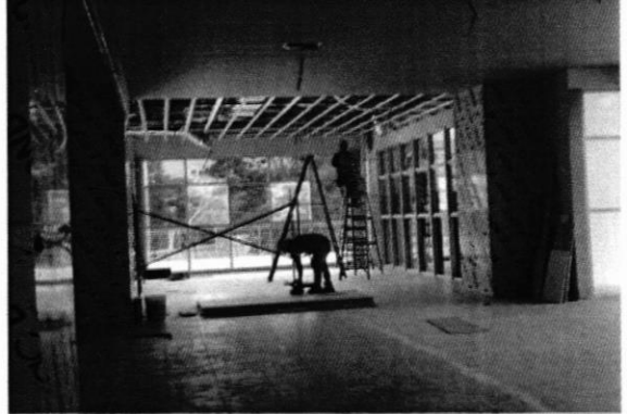
Instalación cielo falso en el área del comedor
