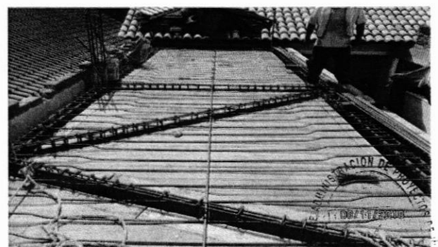
Se prepara armado de la losa del ala norte para fundición, con sus respectivas instaciones
