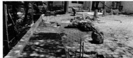
Muro, acera y adoquin en estacionamiento fachada Sur
