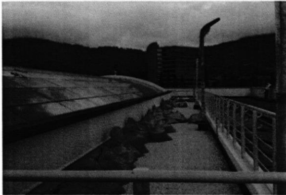
Instalación de grava blanca en azotea
