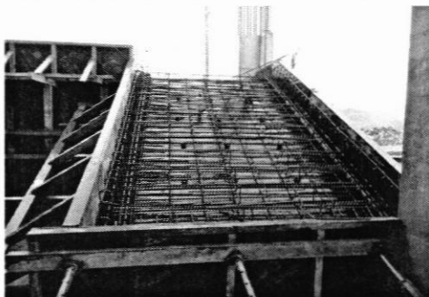
Avance Edificio de Aulas No. 1
