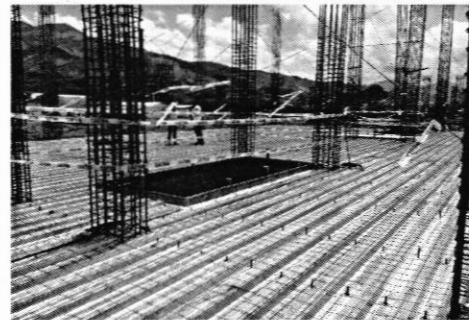
Instalacion de lamina losa cero previo fundir losa , 30 de julio 2018
