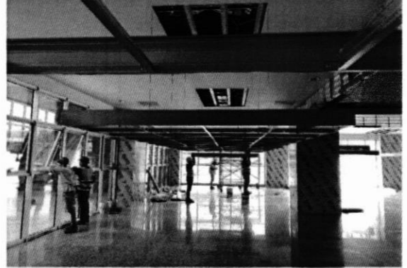
Instalación de cielo nube en comedor.
