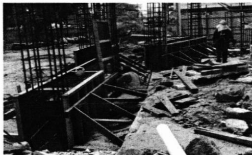
Encofrado vigas VR en el portal peatonal este.
