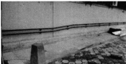
Instalación de pasamanos en acceso principal
