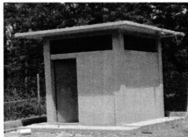
Cuarto de Instalaciones Eléctricas 30-09-2018
