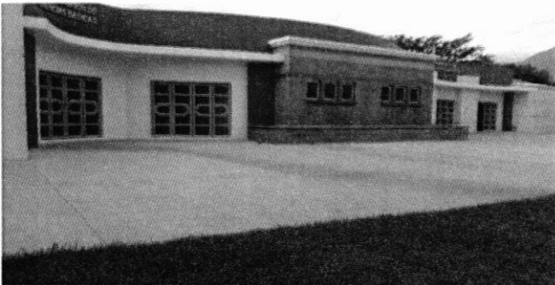
Fachada frontal, Planta Piloto de Innovacion Alimentaria, UNAH-TEC-AGUAN
