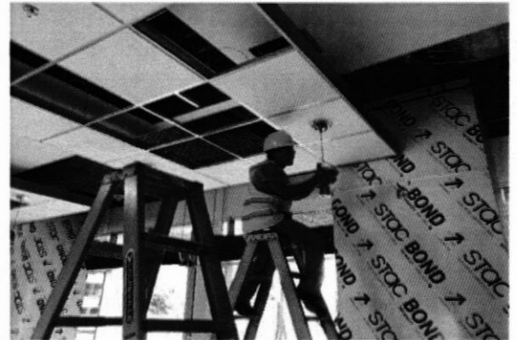
Instalación de luminarias en comedor.
