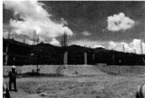
Avance Edificio Administrativo.
