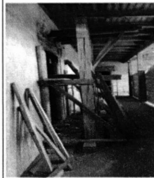
Se continua con la susutitución de los cargadores de madera sobre
