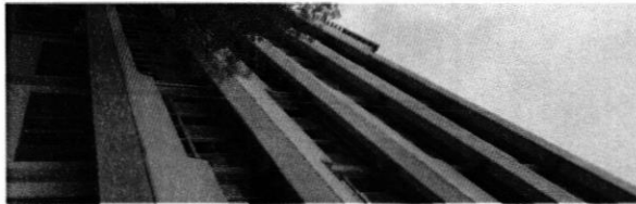
Vista de fachada posterior del edificio Anexo C1
