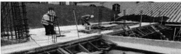
Se fundio losa de azotea, del lado norte
