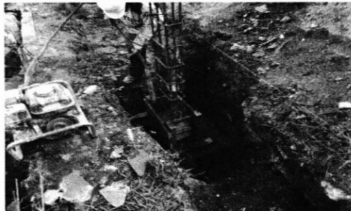
Fundición de pedestales de 30x40x40cms en sector oeste
