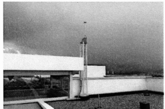
Instalación de pararrayos en Azotea.
