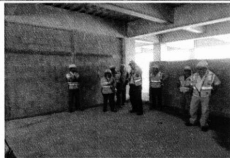
A la izquierda parte avance Edificio Adm. Derecha apertura de calle vehicular.
