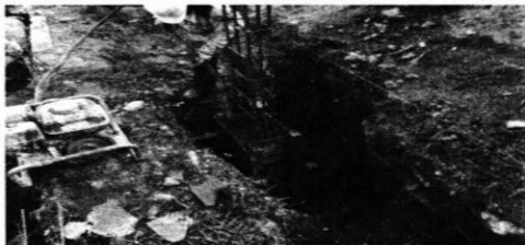
Fundición de pedestales de 30x40x40cms en sector oeste
