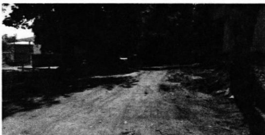
Desvío para circulación de vehículos, por trabajos en lado Este
