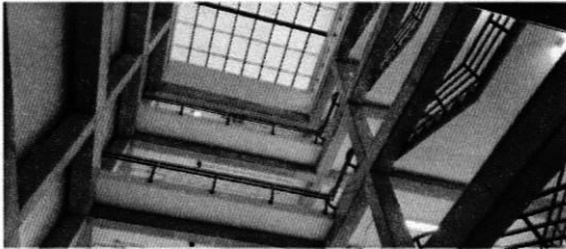
Vista de lucernario Edificio Anexo C1
