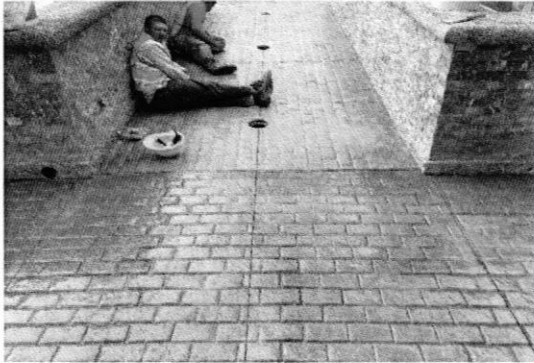
Aplicación de sellador en piso de Azotea.
