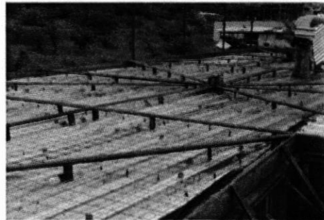
Avance Edificio Administrativo.
