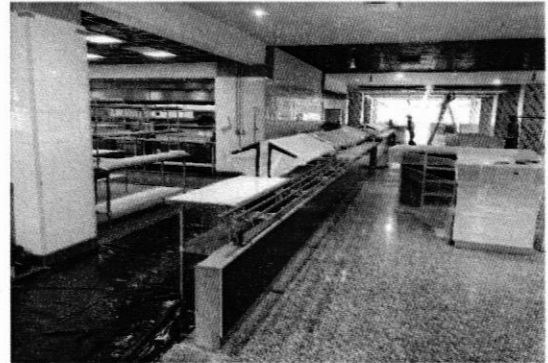
Instalación de bufeteras en Comedor.
