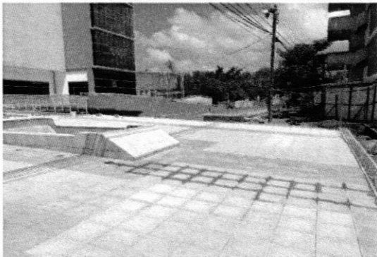
Instalación de terrazo en puente peatonal.
