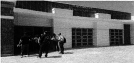
Fachada frontal Planta Piloto de Innovación Alimentaria, UNAH-TEC-DANLI
