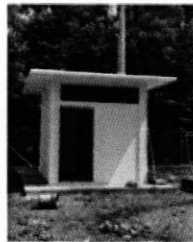
Cuarto de Instalaciones Eléctricas. 30-10-2018
