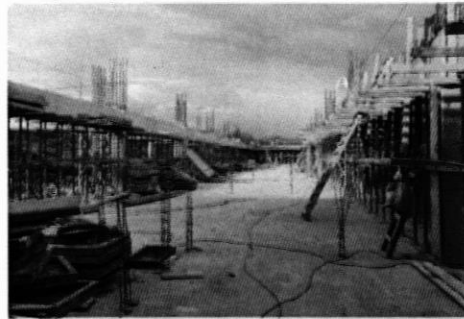
Avance Edificio Administrativo.
