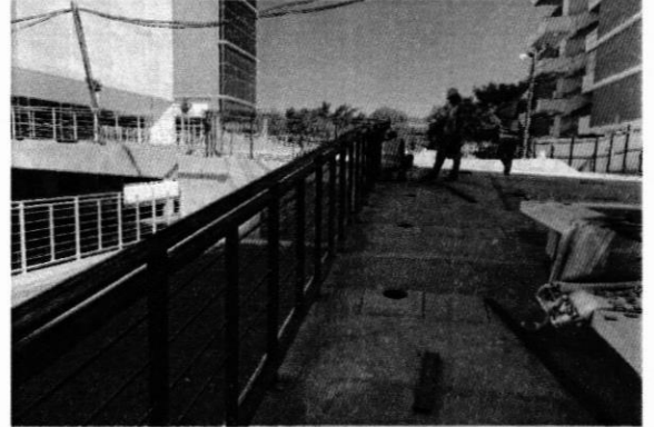
Instalación de barandales en Plaza frente a edificio.
