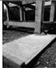
Firme de concreto en salida de la tubería de limpieza del tanque; 30-11-2018
