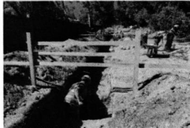
Excavaciones en la colindancia sur
