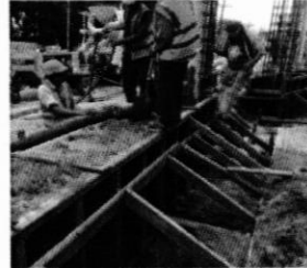
Fundición de tramo de pared en portal peatonal Este
