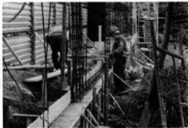
Armado de solera inferior en muro perimetral oeste
