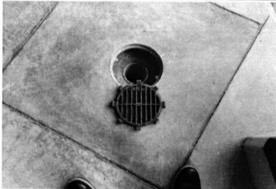
Instalación de coladeras de piso para drenaje.
