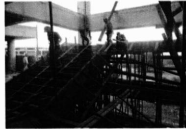
Fundicion de gradas Edificio Administrativo
