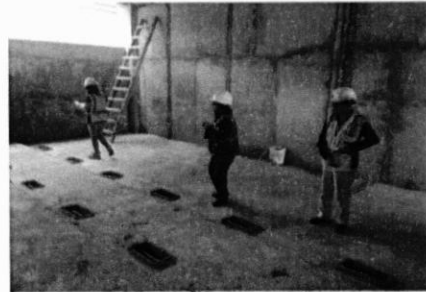
Avance Edificio Aulas No. 1. firmes de concreto y repellos en paredes
