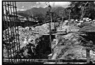
Fundición de Zapatas en lado Sur
