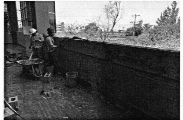
Construcción de pretil para cerramiento en fachada oeste.
