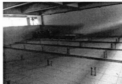
Avance Edificio Aulas No. 1. colocacion de pisos
