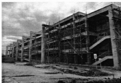
Avance fachada norte
