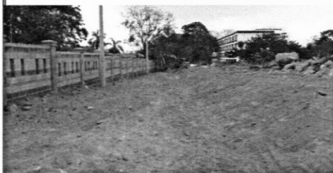
Movimiento de terraceria en lado Nor-Oeste
