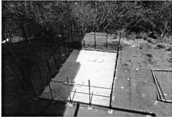
Instalación de cerco de tanque de gas.
