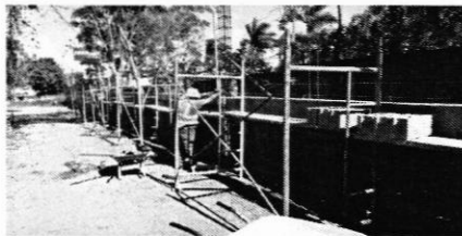
Fundición de soleras y pared de bloque en muro perimetral sector Este
