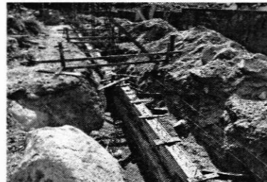
Fundición de Zapatas en lado Sur
