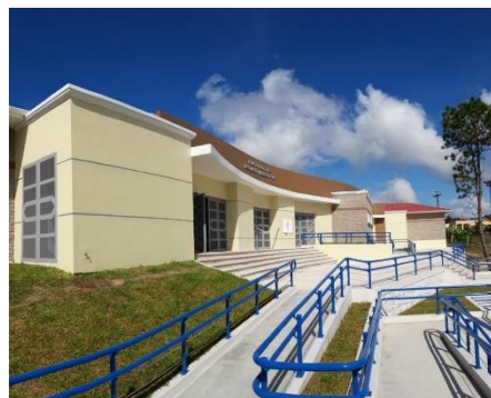
Acceso a Laboratorios de Ciencias Básicas
