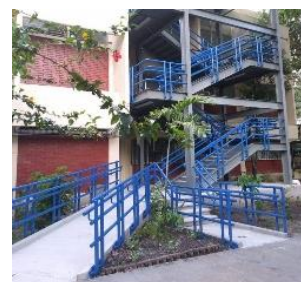
Rampa y gradas construidas
