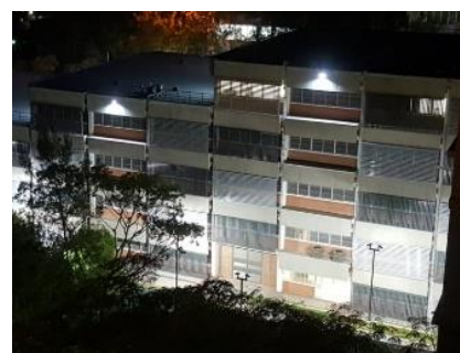
Vista parcial de fachada y plaza sur del edificio
