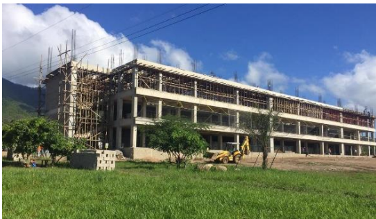
Avance de obra Edificio de Aulas No.1
