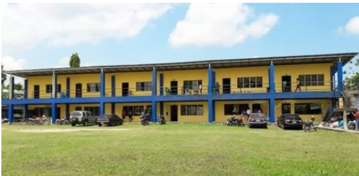
Situación actual Edificio No.1
