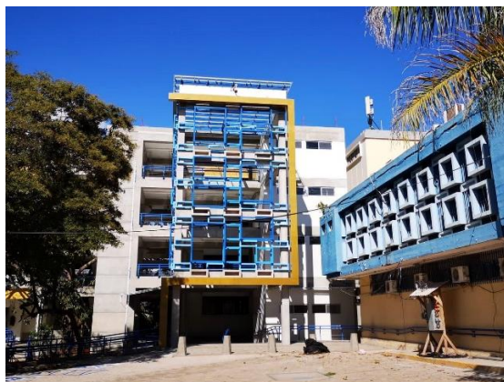
Vista fachada sur, acceso al Edificio Anexo
