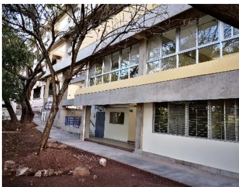
Vista fachada norte del edificio
