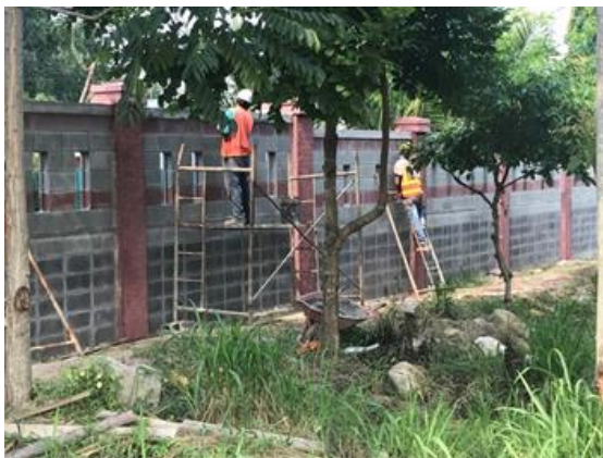
Acabado final en Muro Norte
