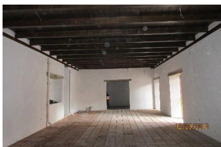
Sala de exposiciones en segundo nivel
