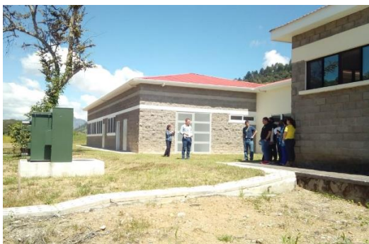
Vista exterior donde se aprecia el transformador de energía con acometida subterránea.
