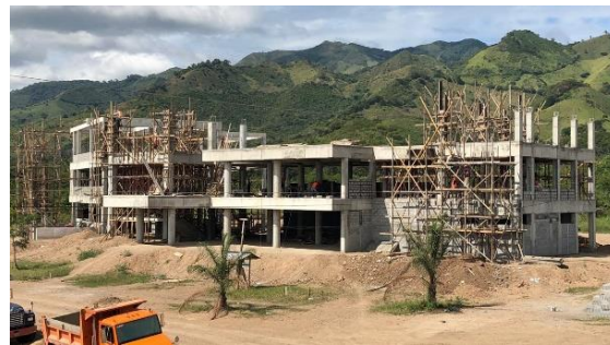
Avance de obra Edificio Administrativo
