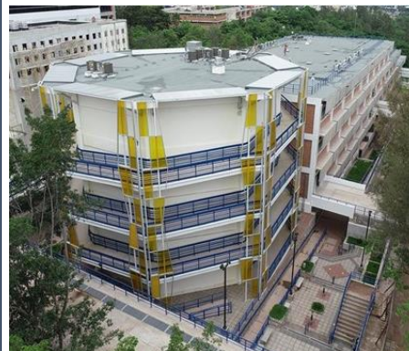
Vista aérea noreste del Edificio. Mostrando el avance de la obra Área total del proyecto: 15,246.39 m 2
