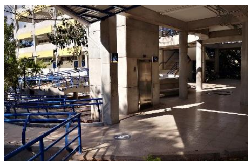
Rampa de acceso a nivel de planta baja y elevador que permiten la accesibilidad a todos los niveles del edificio e incluso al edificio C1 mediante la conexión directa entre ambas edificaciones.
