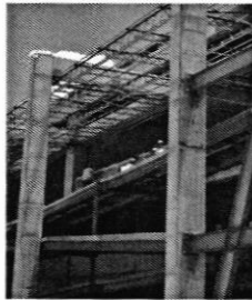
Avance fachada norte
