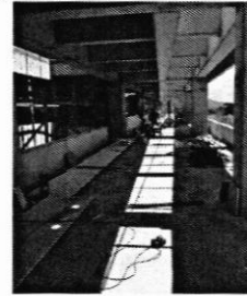
Avance Edificio Aulas No. 1. colocacion de pisos
