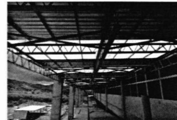
Edificio de Aulas, rampa de acceso.
