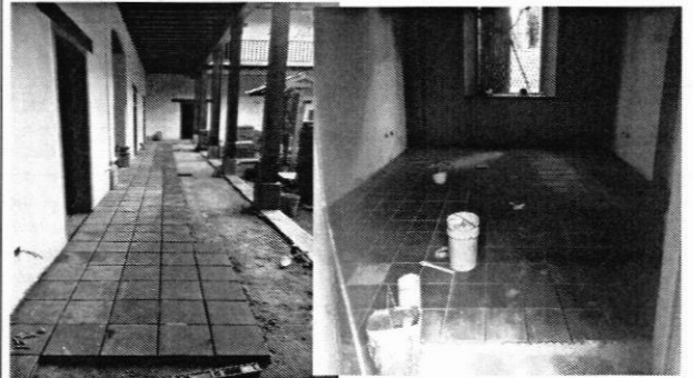
Se termino la instalación del piso de loseta de barro y su fraguado
