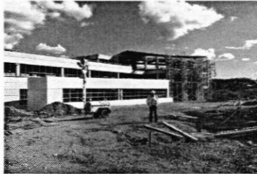
Avance fachada norte, edificio Administrativo
