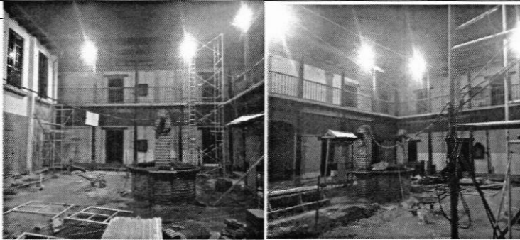
Se trabaja en la instalación de las lamparas y se realizan pruebas de iluminación, entre otros, ya se cuenta con el energizado el Proyecto
