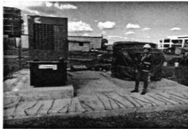
Avances en Edificio AULAS No.1, fachada sur
