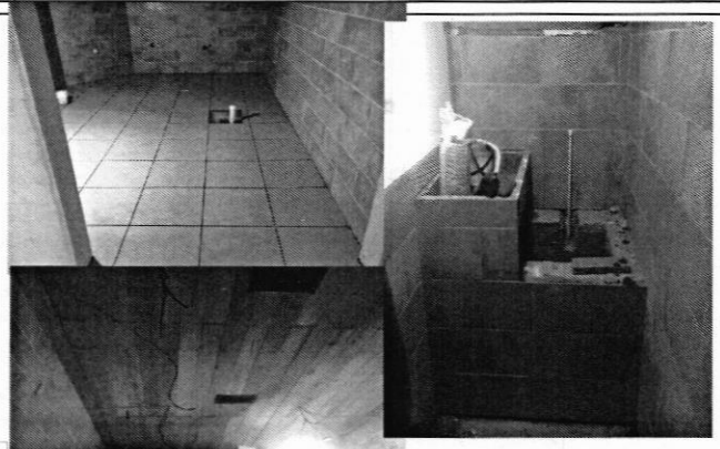
Se termino de intalar el porcelanato de piso de los baños, en las áreas humeda (pileta de aseo) y cielo falso de madera en modulos de baños
