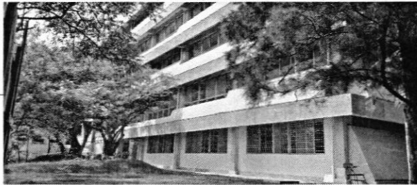
Vista de posterior del Edificio
