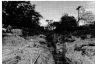
Zapatas en lado Sur
