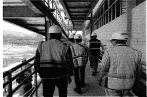
Avance Edificio Aulas No. 1. Rampa de acceso
