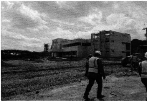
Avances en Edificio Administrativo, fachada sur
