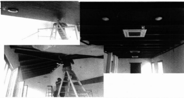
Se trabaja en la pintura de cielos falsos de madera y en la instalación de las lamparas.
