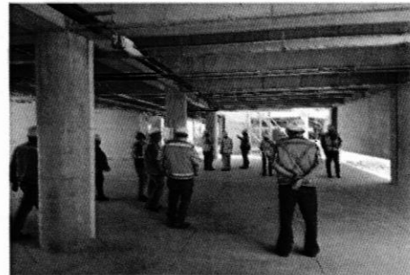
Interior Edificio Administrativo, 1er nivel
