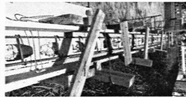
Encofrado de solera superior en esquina Sur
