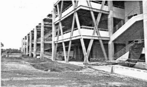
Avance fachada norte, Edificio Administrativo
