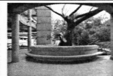
Vista del lobby y banca central
