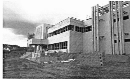
Exterior Edificio Administrativo, 1er nivel
