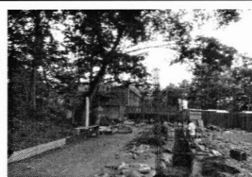
Avance de muro en colindancia Este. area donde se desmonto estacion de buses
