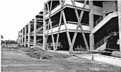
Avance fachada norte, Edificio Administrativo
