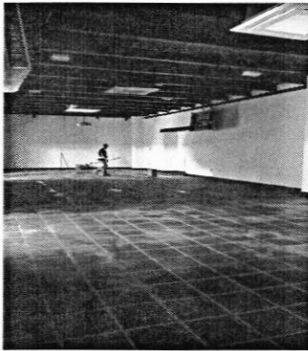
Se realizan trabajos de lavado en los pisos de barro para proceder a intalar el sellador y se ha trabajado en la construcción del revestimiento de las bases de concreto en columnas de madera
