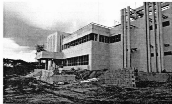
Exterior Edificio Administrativo, 1er nivel
