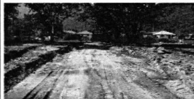
Avance de trabajos de terracería en acceso Oeste
