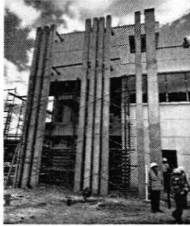
Avance fachada norte, Edificio Administrativo
