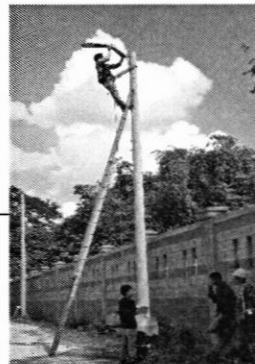
Instalación de luminarias y postes en muro perimetral
