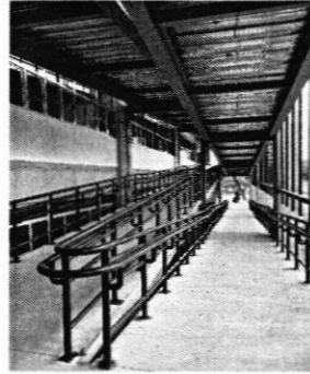
Avance Edificio Aulas No. 1. Rampa de acceso
