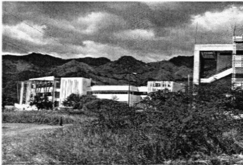
Avances en Edificio Administrativo, fachada sur
