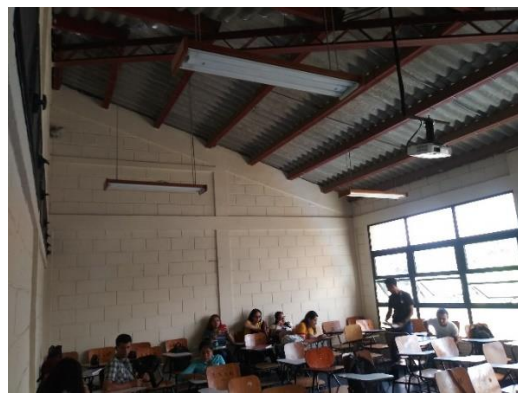
Fotografía N° 2. Aula en segundo nivel del Edificio N° 1
