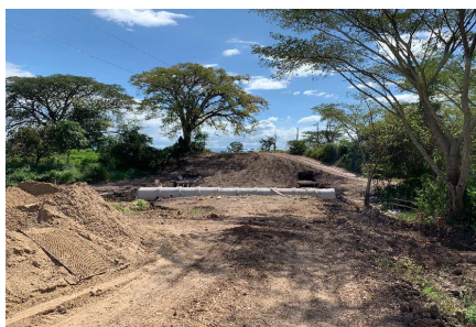
Avance acceso vehicular a predios del nuevo campus curno,
