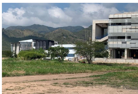
Avances en Edificio Aulas No. 1 , fachada sur
