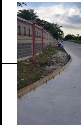
Vista frontal de calle de Concreto Hidráulico en Acceso y salida Oeste y conformación y limpieza en area de aceras
