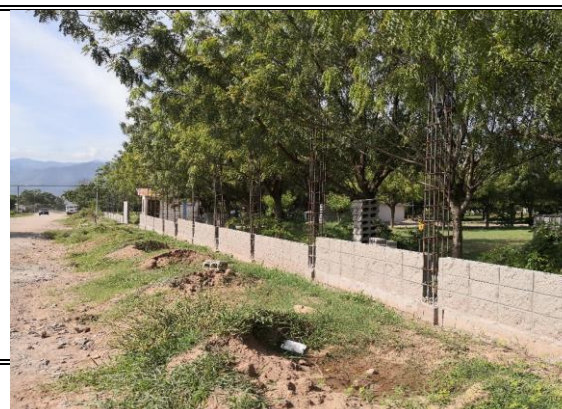
No 4.- Sección "B" del Muro Perimetral
