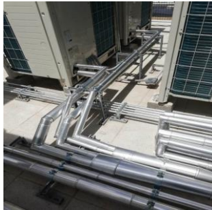
Suministro e Instalación de chaqueta de aluminio para tubería de refrigeración
