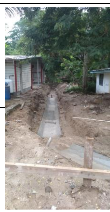
Se observa trabajos de fondo de canal en areas verdes.
