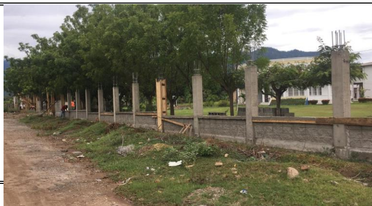
No 3.- Se observan columnas ya construidas
