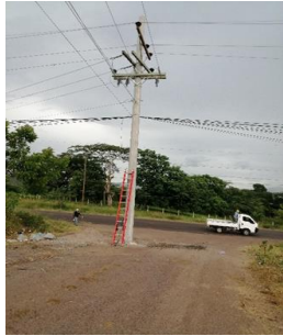
Suministro e instalación de estructura ER-III-1 en 34.5 kv.
