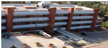
Acabado final en Muro Norte
