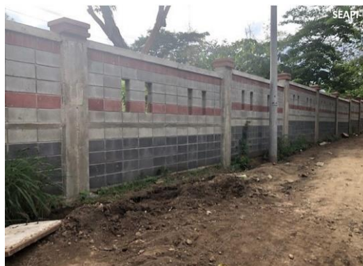
Avance de obra lado sur
