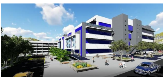
Vista noroeste del Edificio B1
