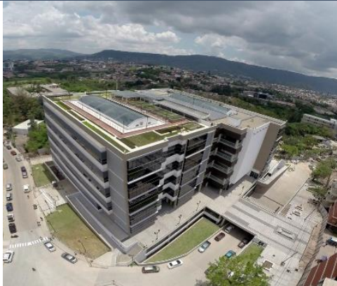
Vista aérea sureste del Edificio 1847
