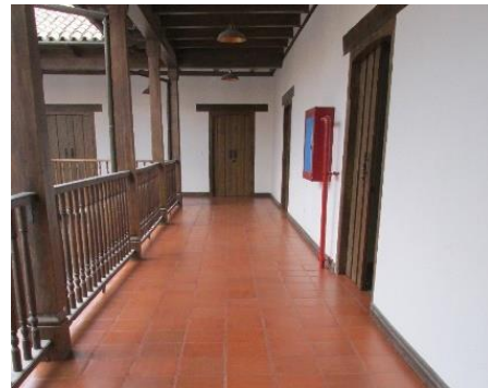
Se instaló loseta de barro en el piso, en pasillo de segundo nivel
