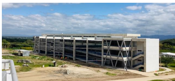
Avance de obra Edificio de Aulas No.1 Se instalaron pisos de terrazo en el Edificio de Aulas
