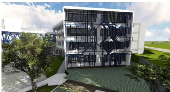
Vista exterior del Edificio E2 donde se ubican los núcleos de aulas y laboratorios
