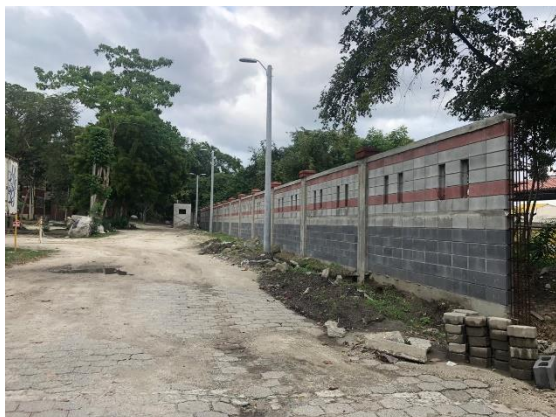
Acabado final en Muro Este
