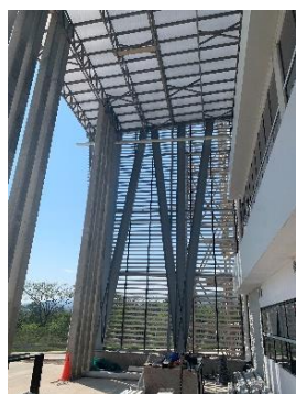
Vista interior área de matrícula, Edificio Administrativo
