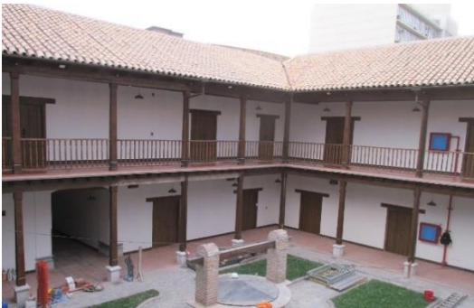
Se culminaron los trabajos en el patio interno; engramado, enchape de piedra, capiteles de concreto para columnas de madera y restauración de pozo.
