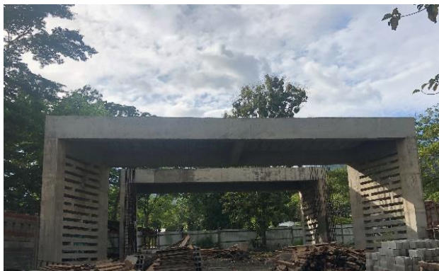
Avance de Portal de Acceso Este
