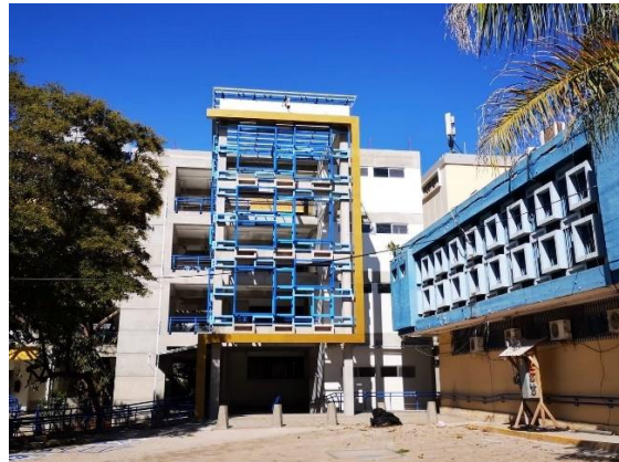
Vista fachada sur, acceso al Edificio Anexo
