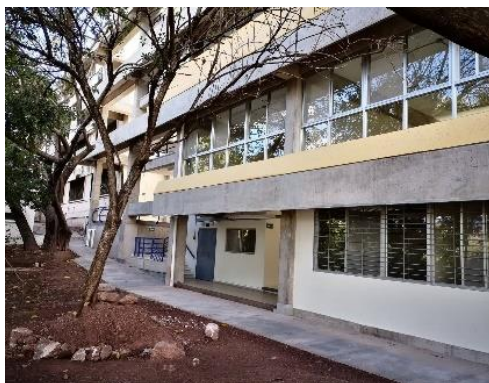
Vista fachada norte del edificio
