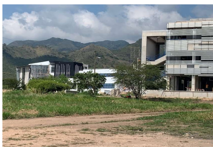
Avances en Edificio Aulas No.1 , fachada sur
