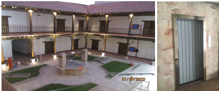
Se trabaja en labores de limpieza final y se atienden las observaciones realizadas por los Especialistas de la SEAPI
