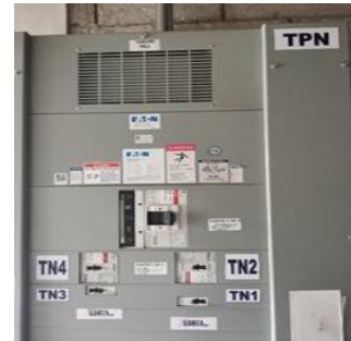
No 2.- Instalación de paneles para el control de iluminación
