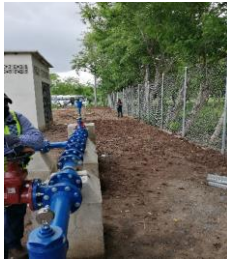
Tren de salida de Línea de Conducción. Realizando la prueba hidrostática a lo largo de línea de bombeo.
