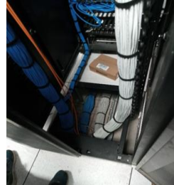
Instalación de cableado en Data Center.
