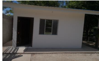
No 4.- Caseta de vigilancia
