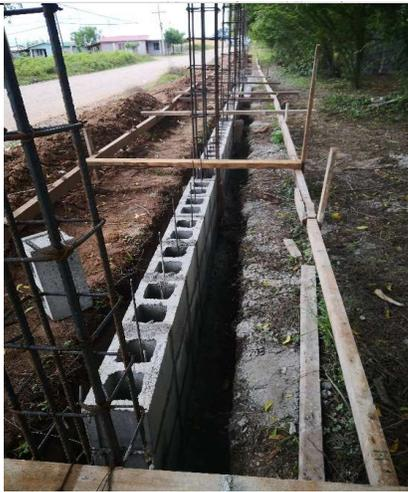
No 1.- Sobrecimentación de bloques de 8", sector D del muro perimetral
