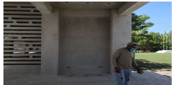
No 4.- Pared perforada de concreto
