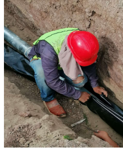
Trabajos de limpieza de tubería para instalación de tubería, carretera principal.
