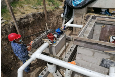
Construcción de cajas de inspección de la línea de conducción de agua pozo.
