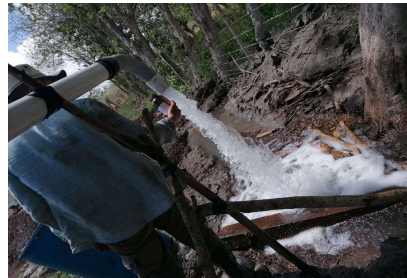
Prueba de tubería agua de pozo línea de conducción.
