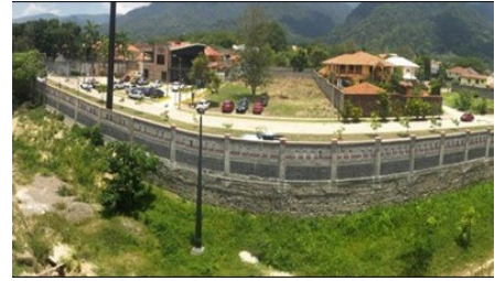
Muro lado Oeste, portón de acceso vehicular y caseta de vigilancia
