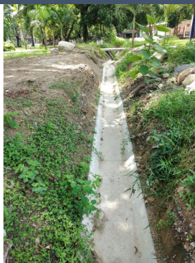
Canal de aguas lluvias
