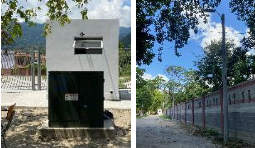
Muro lado Este y portón de acceso vehicular
