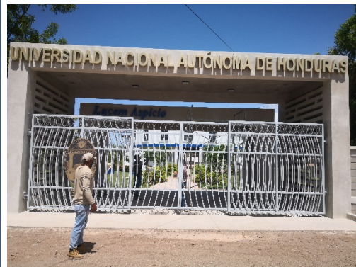
Portal de acceso peatonal El portal consiste en losas de concreto reforzado y paredes perforadas de concreto.
