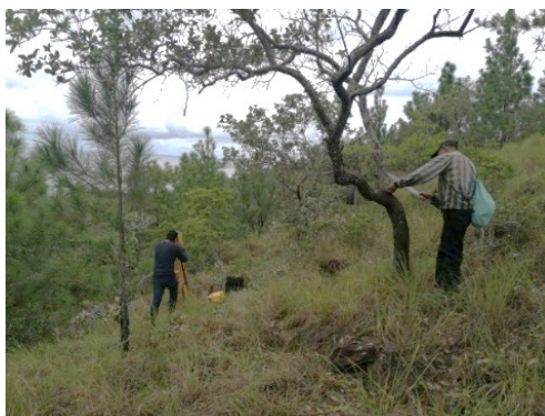
Vista de levantamiento topográfico de línea de conducción del sistema de abastecimiento de agua potable de Cayo Bonacca.
