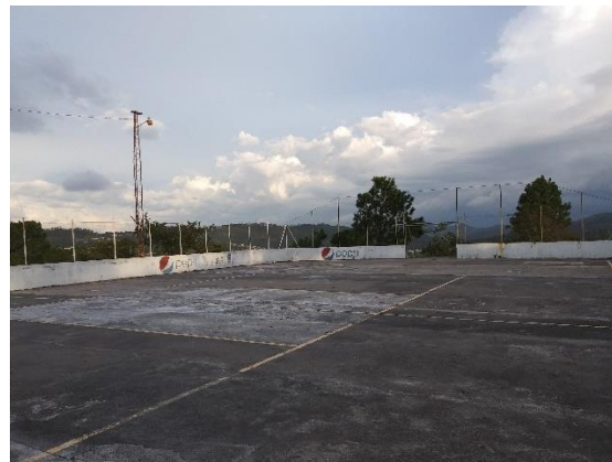
Fotografía N° 2. Vista interior 1 Cancha Multiusos
