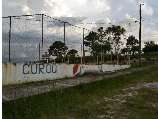
Fotografía N° 1. Vista exterior Cancha Multiusos
