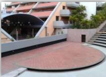
También se realizaron varios trabajos exteriores como la construcción de rampas y cubiertas para
