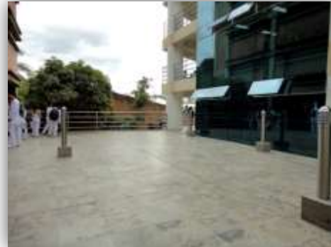
El edificio posee 15 aulas con capacidad de 60 alumnos cada una y 2 auditorios.
