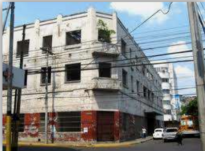
El edificio data de los años 40. Su estado al momento de la restauración era delicado y requirió de trabajos especializados en su estructura y acabados.
